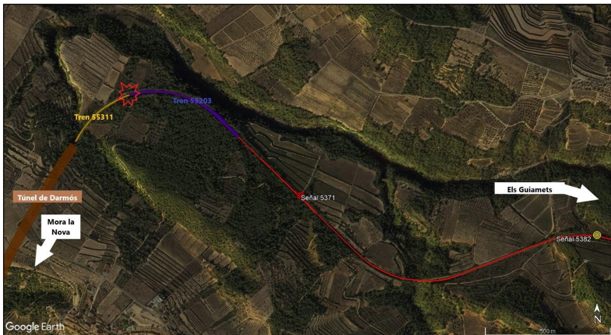
Imagen 8 Detalle de las infraestructuras en la zona del accidente. La ubicación de los trenes es aproximada,
