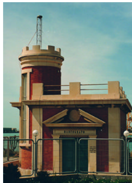
Edificio del mareógrafo de Alicante
