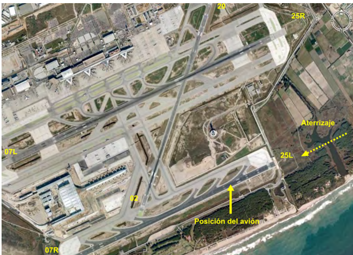
Figura 8. Aeropuerto de Barcelona
