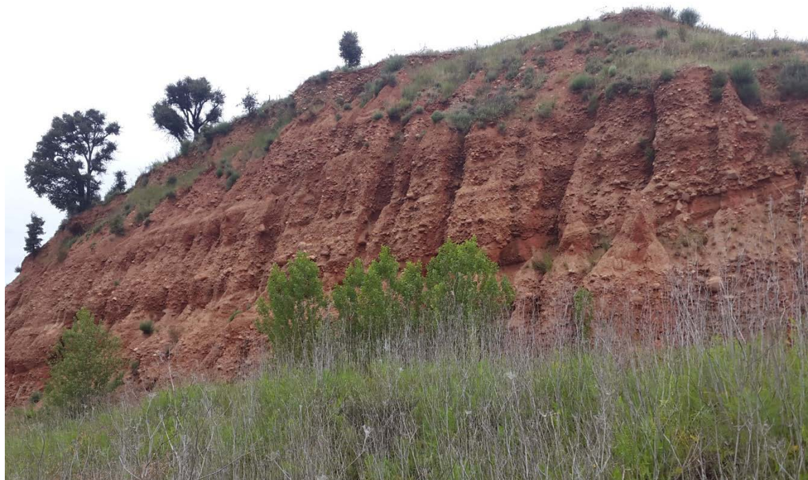
Fotografía.. Materiales terciarios de unidad T_{GA} predominantes en el trazado proyectado.
