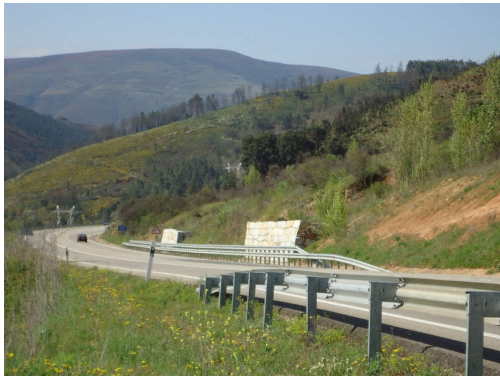
Fotografía Muros de "perpiaños" sujetando sendos deslizamientos, cerca del inicio del tramo
