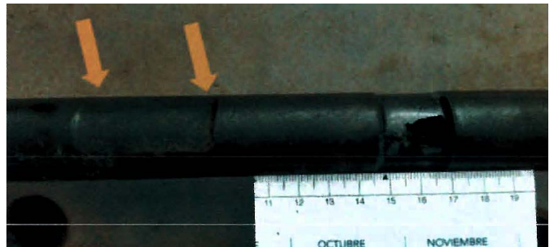
Figura 15. Daños en diciembre de 2019.
