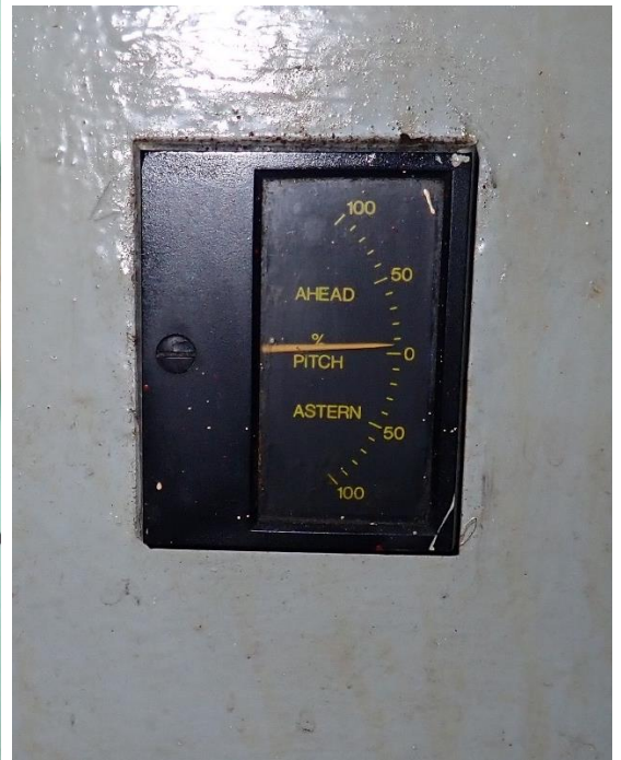
Figura 19. Indicador del paso de la hélice en la unidad de potencia hidráulica en la cámara de máquinas
