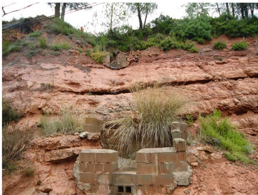
Detalle del estado de un dissipador de energía
