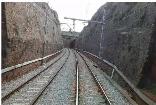
Segunda zona de la trinchera. Sentido creciente de la kilometración
