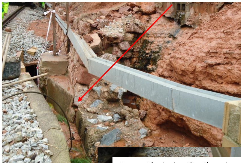
Cimentación de electrificación en la cuneta derecha
