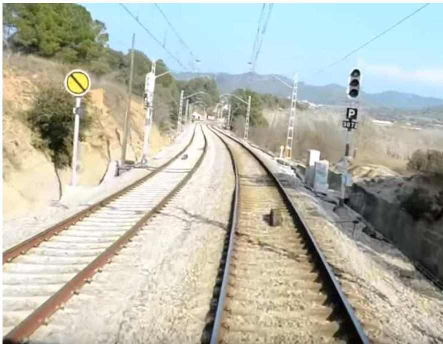
Figura 31: Señal E'4 (a la izquierda), poco antes del apeadero de Castellgali
