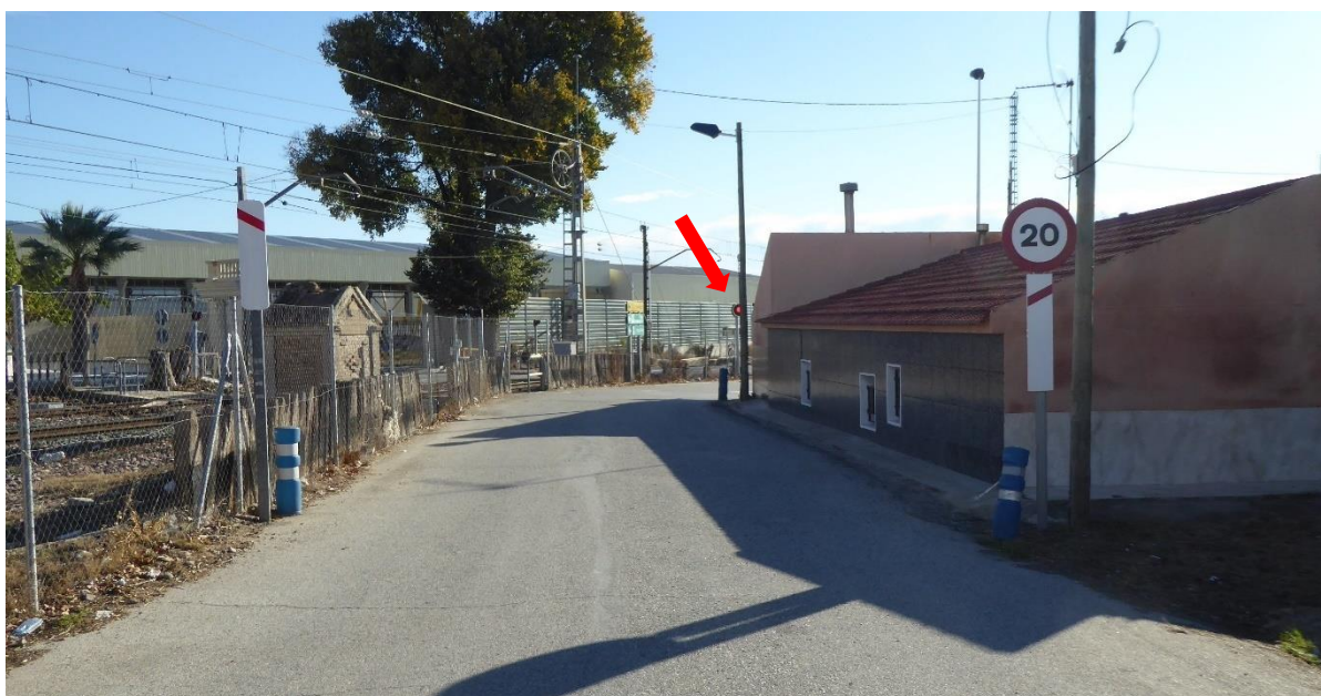
Figura 15: Señalización del paso a nivel poco antes de la señal de proximidad de 50 m. La visión del foco de la señal luminosa puede verse oculta por el poste de alumbrado o la esquina de la casa, dependiendo de la trayectoria que siga el conductor.
