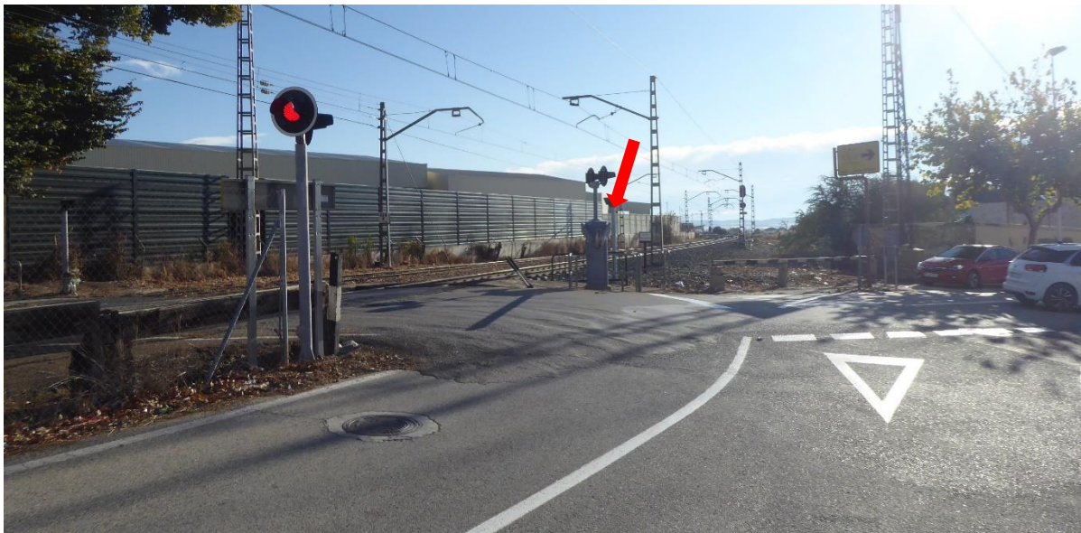
Figura 19: Vista de la semibarrera bajada, desde la calle Rafael Altamira (la posición del sol en la fotografía no se corresponde con la del momento del accidente).
