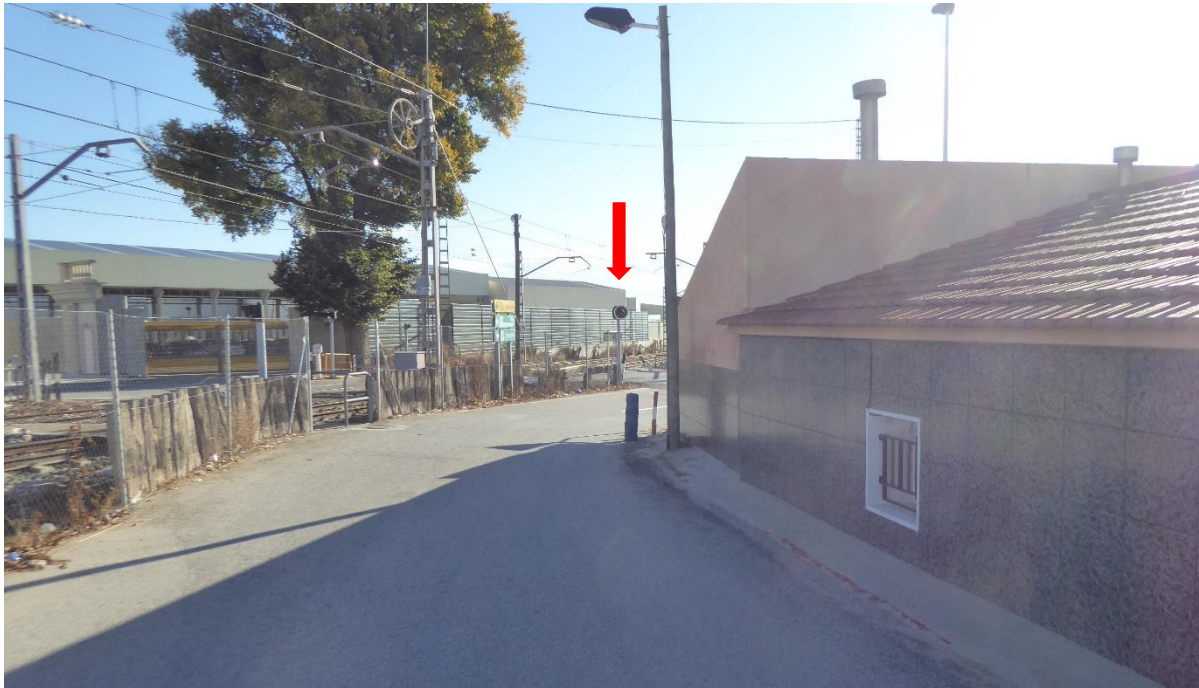
Figura 16: Vista de la señal luminosa, una vez superada la señal de proximidad de 50 m. La línea visual vuelve a estar despejada.
