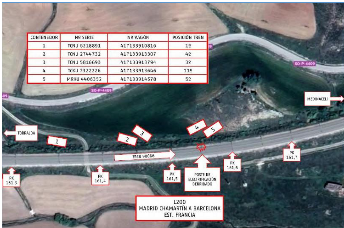
Figura 12: Vista aérea de la situación de los contenedores caídos (fuente ADIF).
