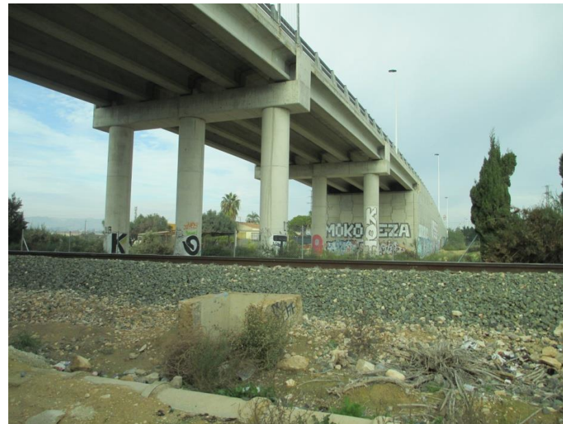
FOTO 11. PK. 0+380. PS para camino previsto para doble vía de ancho UIC
