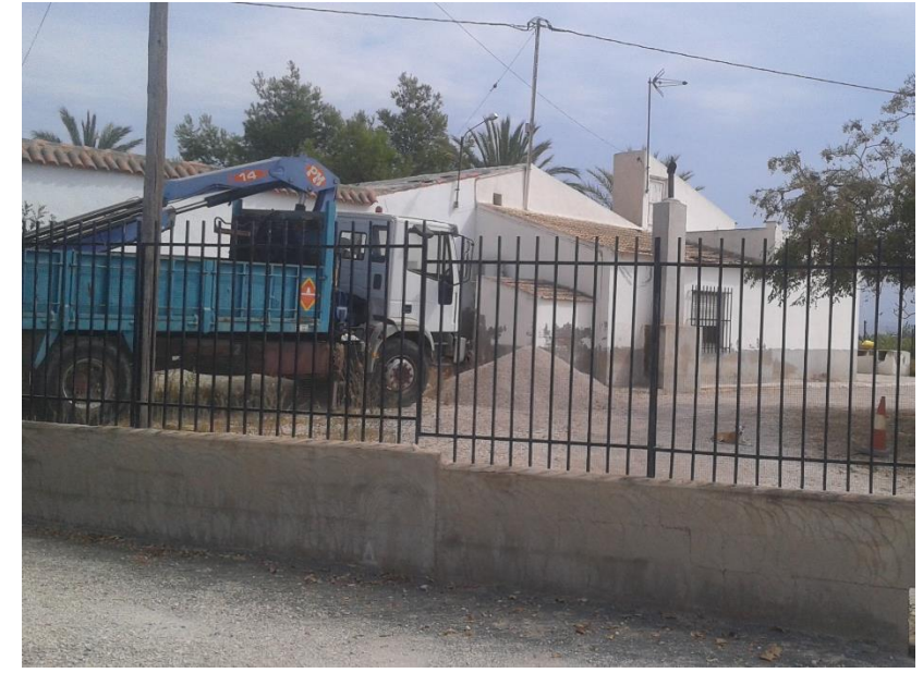
FOTO 39. PK. 2+840. Afección a vivienda
