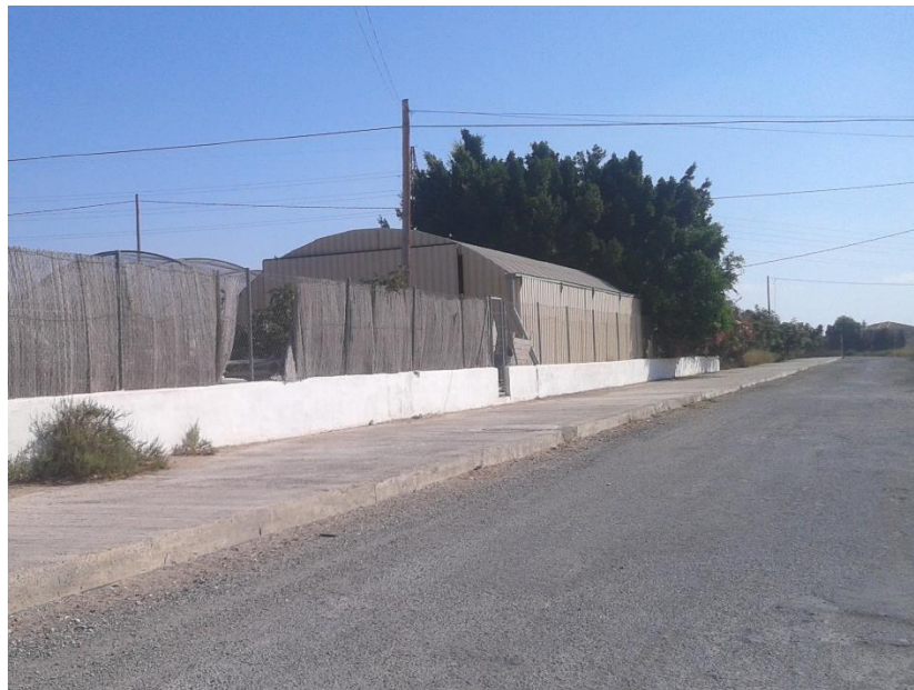
FOTO 34. PK. 2+000. Afección a vivienda y nave
