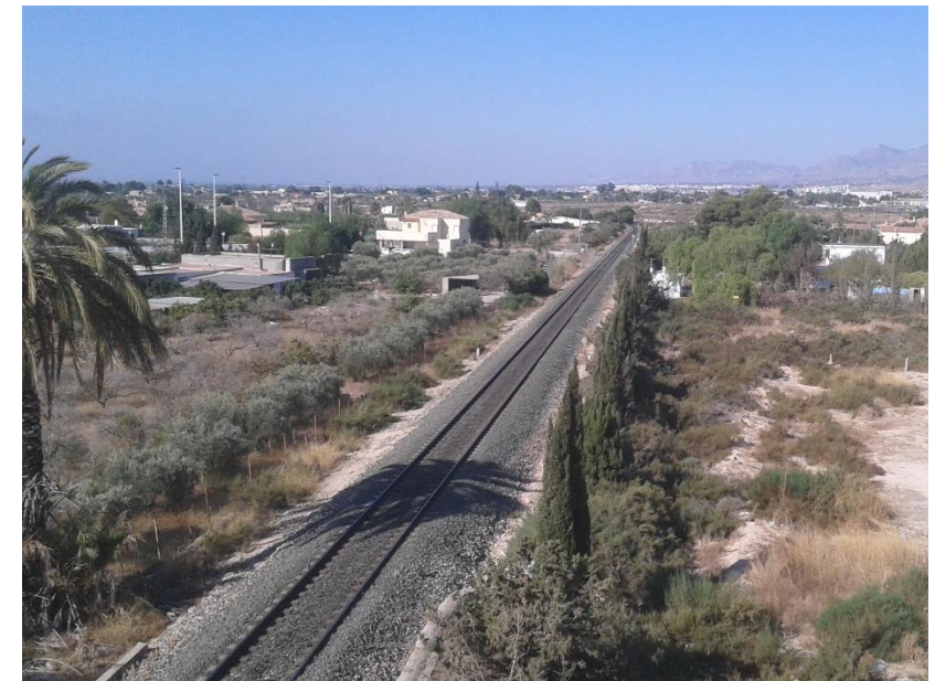
FOTO 12. PK. 0+380. Vista de la traza, sentido Crevillente
