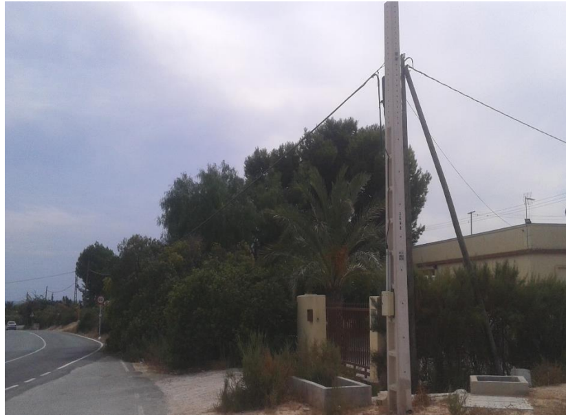
FOTO 49. Vista edificación situada en Vereda de Santa Teresa
