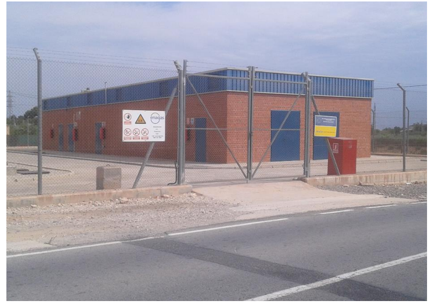
FOTO 48. Instalaciones de ENAGAS
