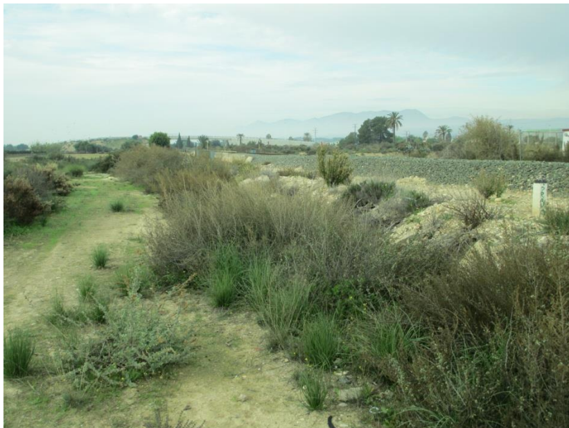
FOTO 10. PK. 0+100. Vista de la traza ferroviaria y del PS situado en el PK. 6+800
