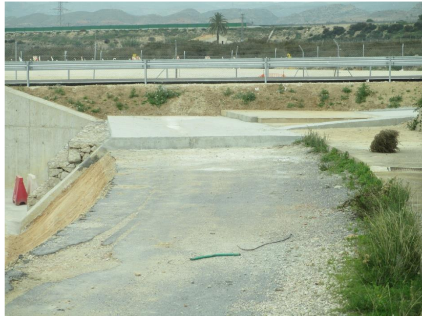
FOTO 47. Canal de Riegos de Levante antes del cruce de la nueva plataforma LAV
