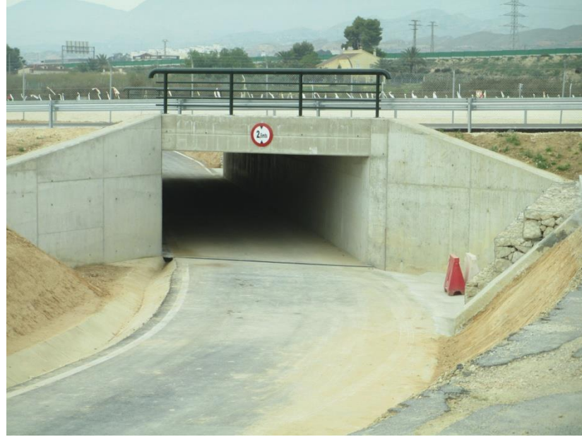
FOTO 44. PI de la nueva plataforma LAV para el camino de servicio del canal de Riegos de Levante
