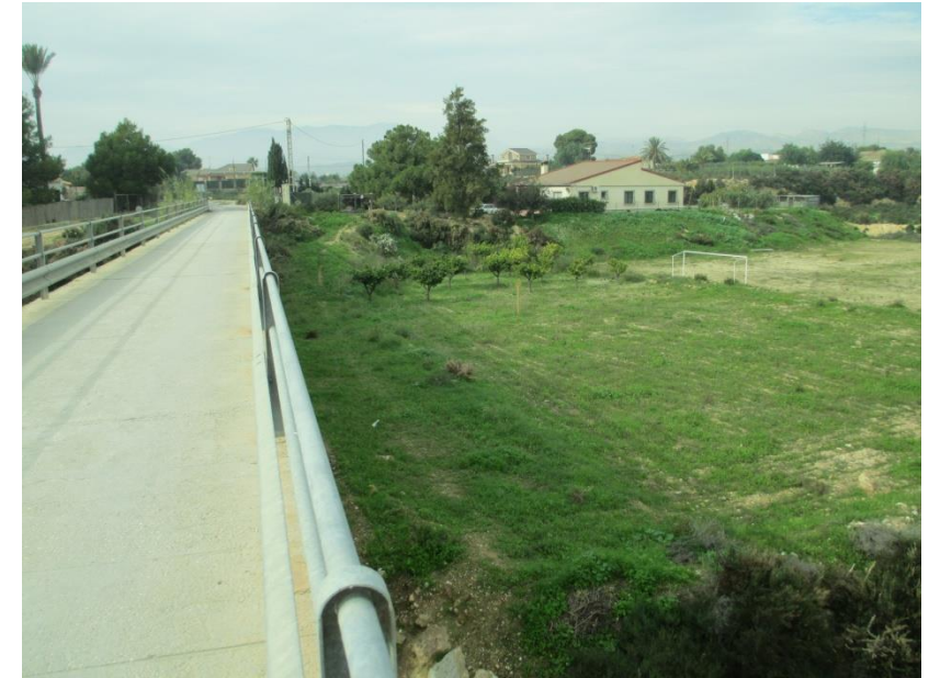
FOTO 33. PK. 2+260. Zona de la traza sobre el barranco de Barbasena. Afección a edificación
