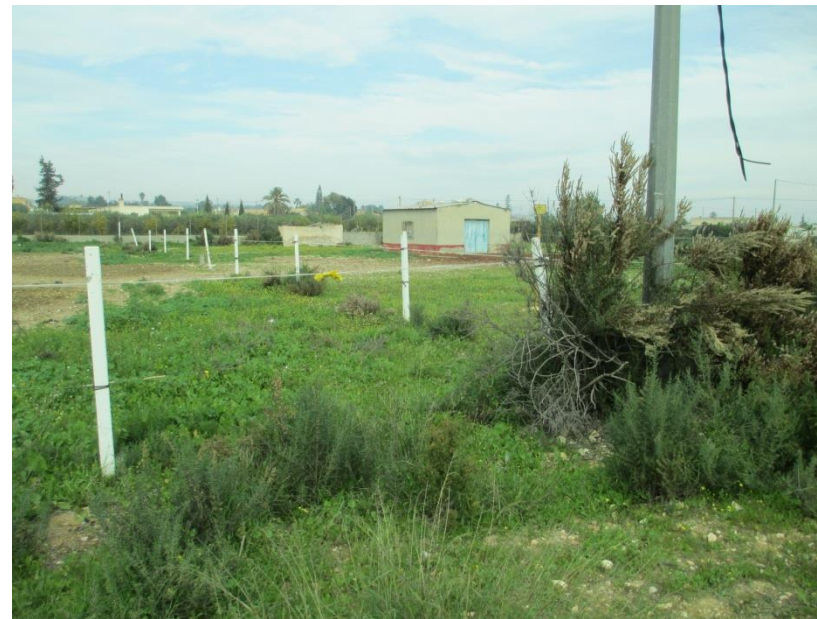
FOTO 29. PK. 1+900. Afección a cobertizo
