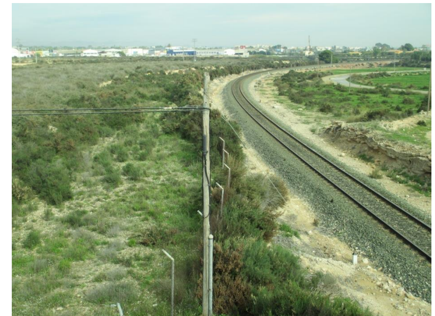
FOTO 18. PK. 1+370. Vista sentido centro urbano de Elche
