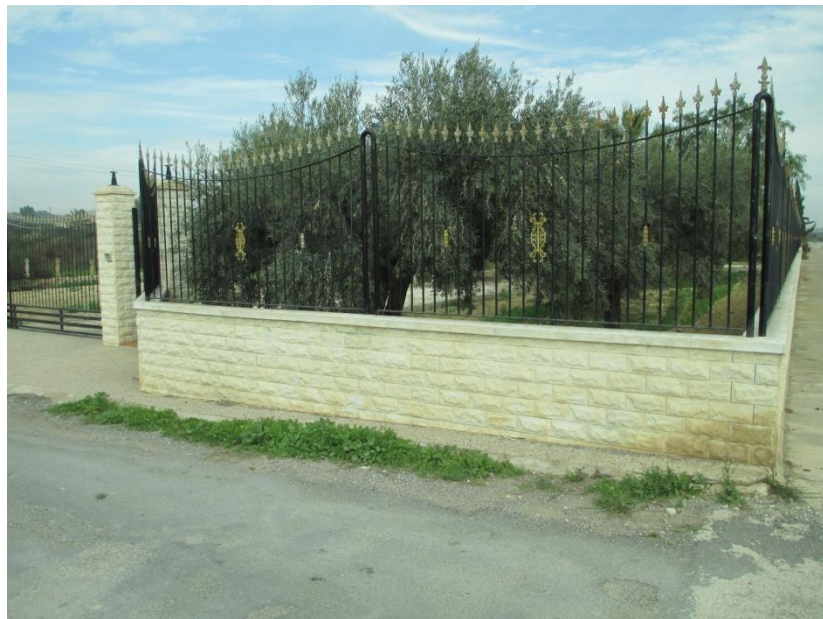
FOTO 28. PK. 1+800. Afección a edificación
