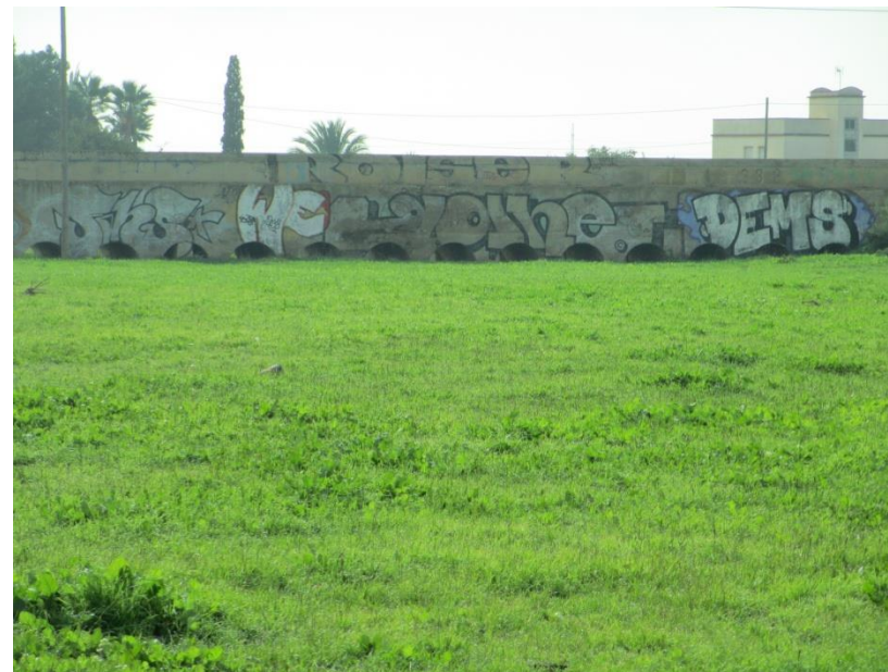
FOTO 17. PK. 0+940. Vista del canal de Riegos de Levante
