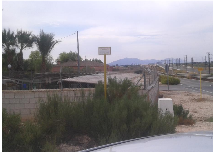
FOTO 55. PK. 3+270 MI. Vista camino de servicio, edificaciones y gasoducto
