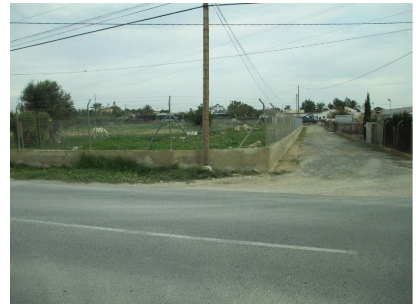
FOTO 42. PK. 2+840. Afección a vivienda
