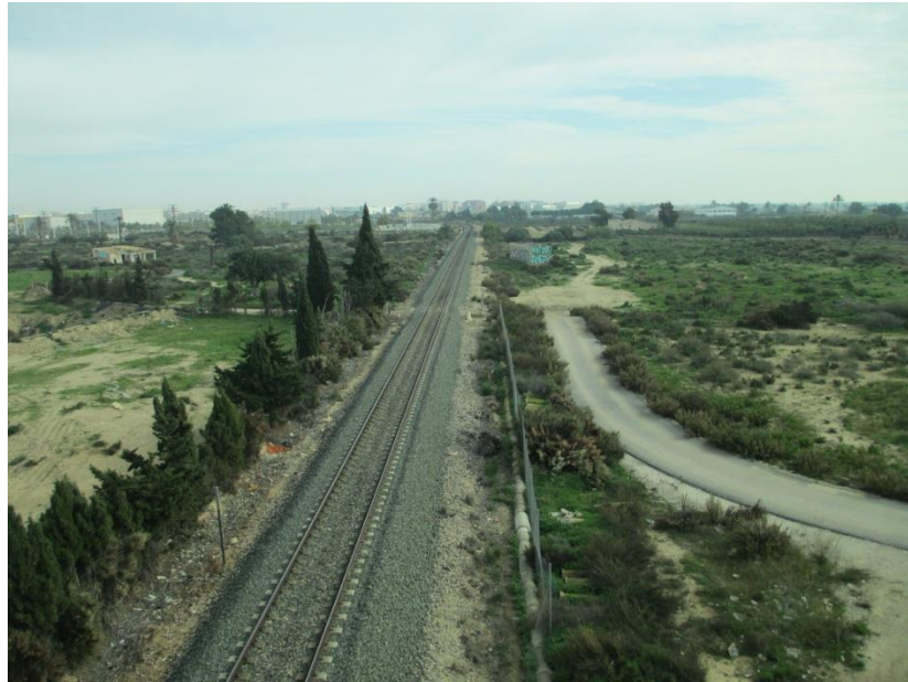
FOTO 13. PK. 0+380. Vista de la traza, sentido centro urbano de Elche
