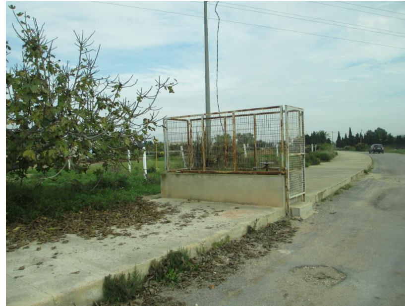
FOTO 26. PK. 1+900. Instalaciones asociadas al canal de Riegos de Levante
