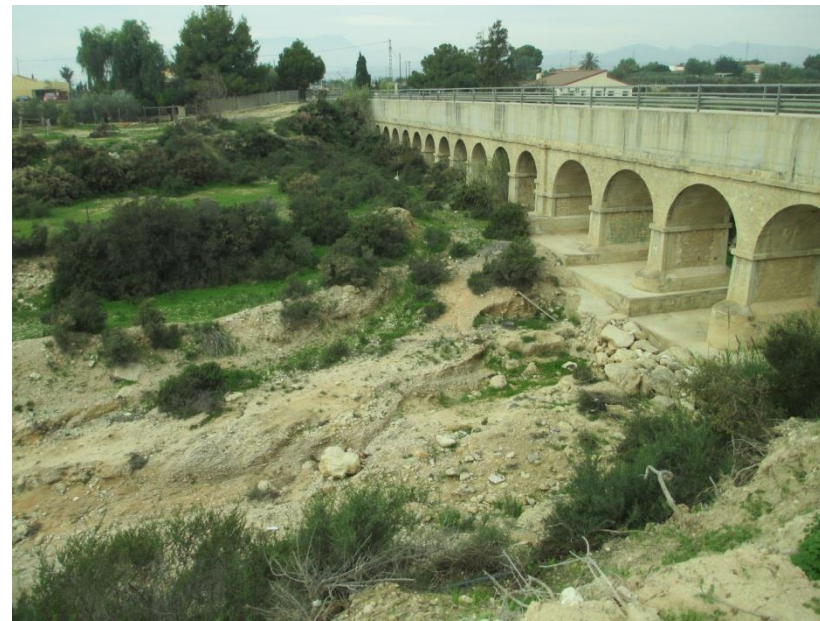
FOTO 35. PK. 2+260. Estructura sobre barranco de Barbasena. Vista desde aguas abajo de la estructura
