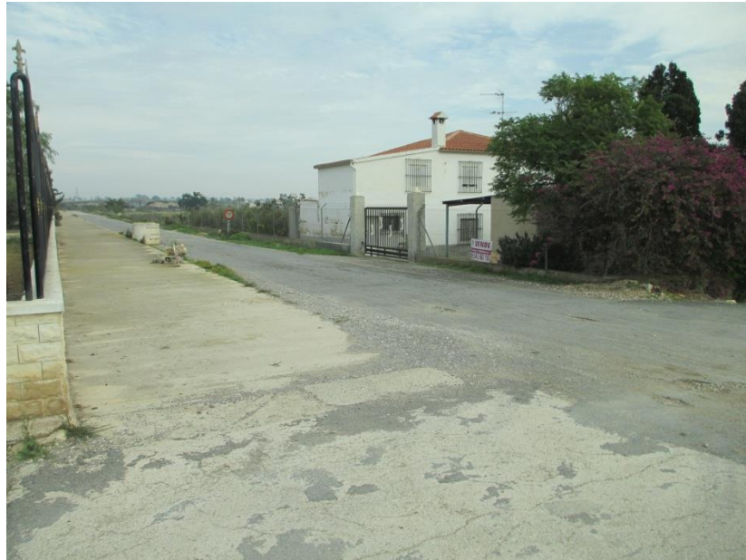
FOTO 25. PK. 1+800. Vista de la zona de la traza ferroviaria entre edificaciones, sentido centro urbano de Elche: Afección a edificaciones
