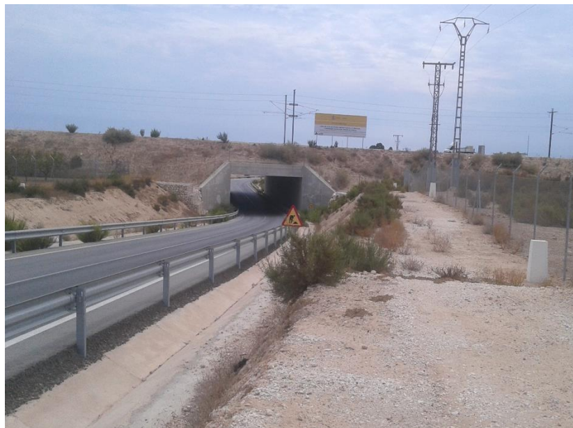
FOTO 52. Reposición canal de Riegos de Levante y su camino de servicios, bajo la plataforma LAV
