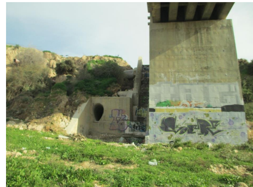
FOTO 6. PK. 0+050. Estructura sobre el barranco de Las Monjas. Bajante escalonada de hormigón y desagüe, aguas arriba de la estructura
