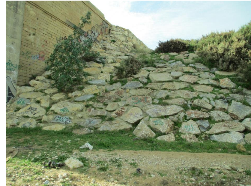
FOTO 3. PK.0+050. Estructura sobre el barranco de Las Monjas. Protección de escollera, aguas arriba de la estructura
