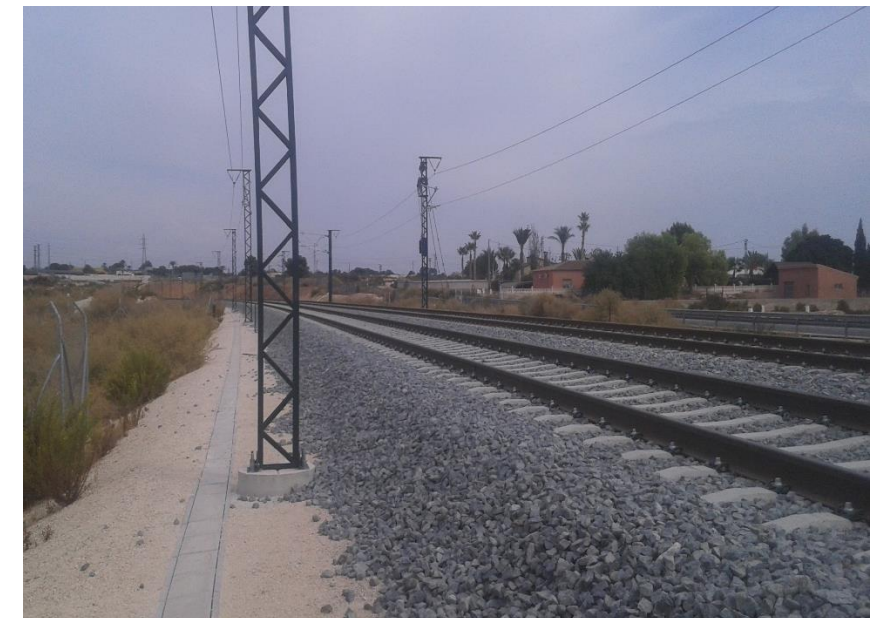
FOTO 54. Vista de la nueva plataforma LAV y edificaciones que acceden al camino de servicio
