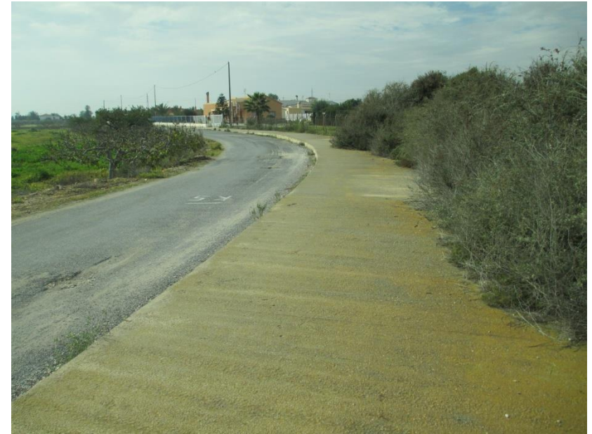
FOTO 21. PK. 7+840. Vista del camino de servicio y del canal de Riegos de Levante, sentido nueva estación Elche Alta Velocidad
