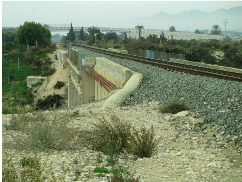
FOTO 1. PK. 0+050. Estructura sobre el barranco de las Monjas. Vista de la zona de aguas abajo. Servicios existentes
