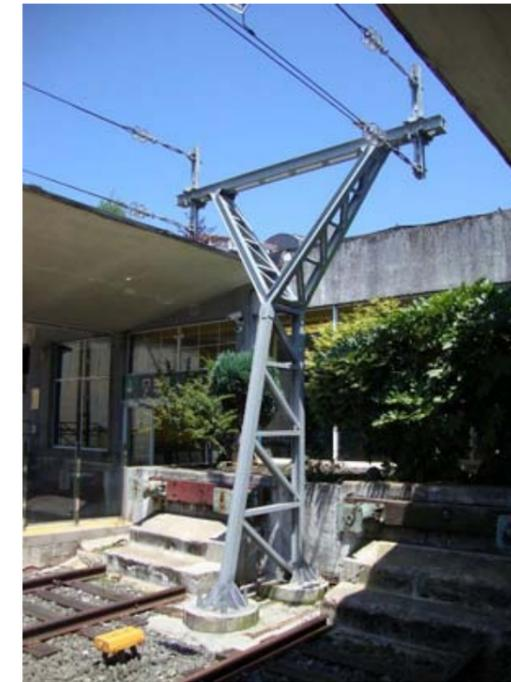
Fotografía Nº 88. Electrificación ente vías en la estación de ADIF RAM.
