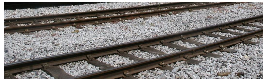
Las vías de ancho ibérico la conforman carril RN45 con traviesa de madera con sujeción rígida asentada sobre una banqueta de balasto silíceo de 20 cm de espesor y 90 cm de hombro.
