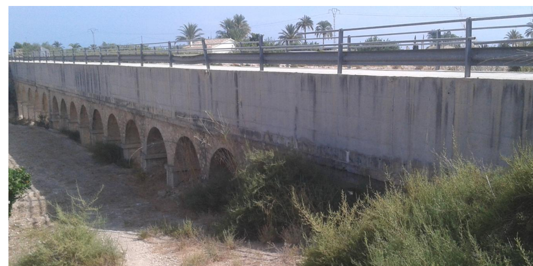
FIGURA 2. BARRANCO DE BARBASENA. VIADUCTO SITUADO AGUAS ABAJO DE LA TRAZA DE LAS ALTERNATIVAS 1 Y 2
