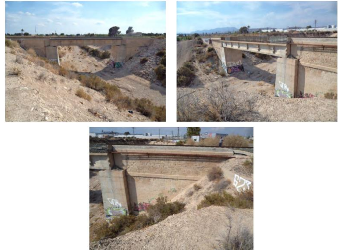
FIGURA 11. PONT SOBRE LA BARRANC DELS ARCS O DE LES MONGES (COD. Nº 66). VISTAS GENERALES DE LOS DOS LADOS DEL VIADUCTO (IMÁGENES SUPERIORES) Y DETALLE DE SU FÁBRICA CONSTRUCTIVA (IMAGEN INFERIOR)
