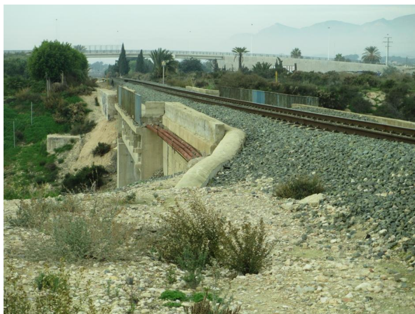
FIGURA 28. ESTRUCTURA SOBRE EL BARRANCO DE LAS MONJAS. ZONA DE AGUAS ABAJO. SERVICIOS EXISTENTES
