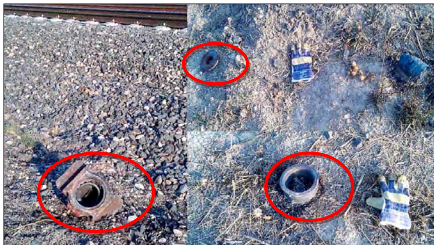
Restos de la caja de grasa, rodamiento y mangueta del eje encontrado en el PK 42+845. (Fuente Adif)
