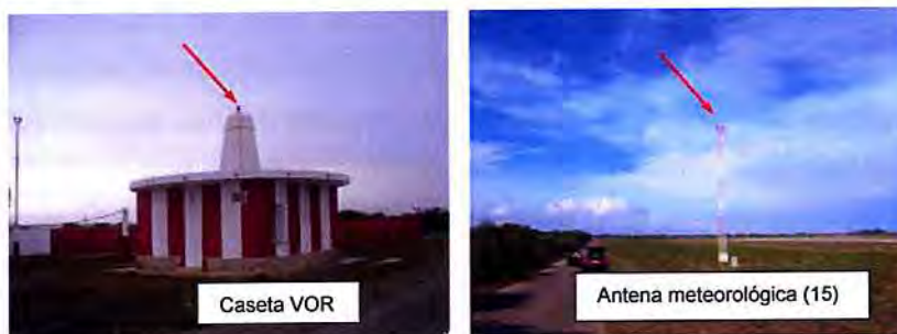
Ilustración 5.3- Caseta VOR y antena meteorológica situados en el interior de la franja de pista
