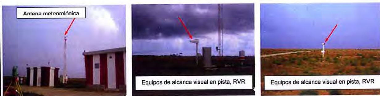
Ilustración 5.4 Antena meteorológica, equipos de alcance visual en pista (RVR) situados en el interior de la franja de pista
