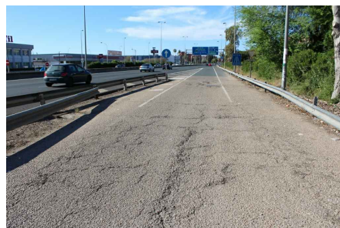
ZONA A FRESAR Y REPONER EN LA SALIDA DE LA ESTACION DE SERVICIO
