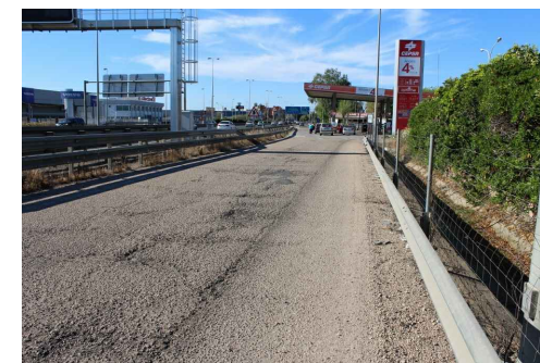
ZONA A FRESAR Y REPONER EN LA ENTRADA DE LA ESTACION DE SERVICIO
