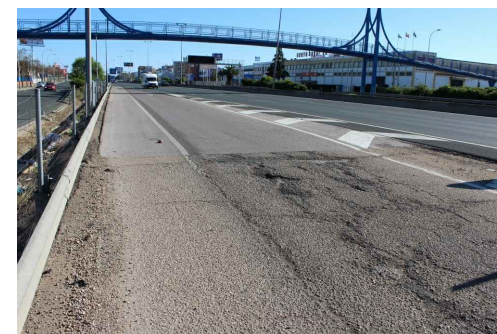
ZONA A FRESAR Y REPONER EN LA ENTRADA DE LA ESTACION DE SERVICIO
