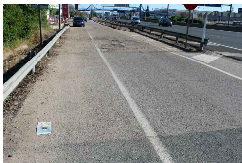
ZONA A FRESAR Y REPONER EN LA SALIDA DE LA ESTACION DE SERVICIO
