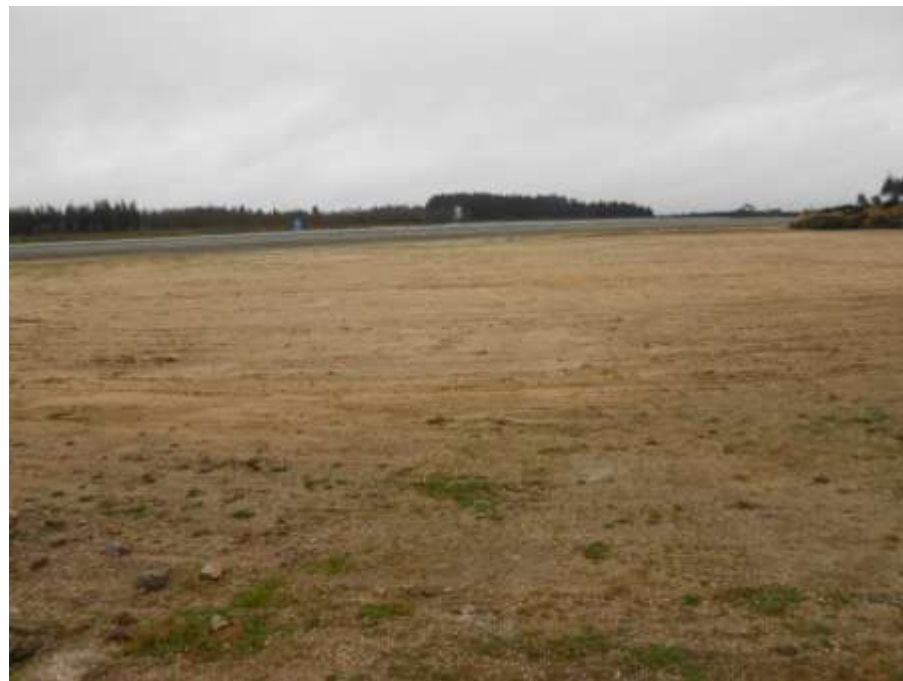
Foto 19: Margen izquierda. Explanación.
