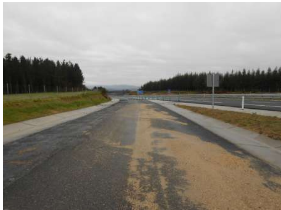
Foto 7: Margen izquierda. Ramal de acceso a la semiárea y cunetas.
