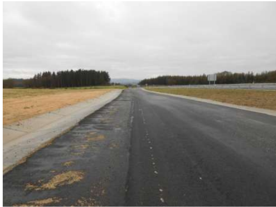
Foto 13 Margen izquierda. Zona de la entrada y salida proyectadas.
