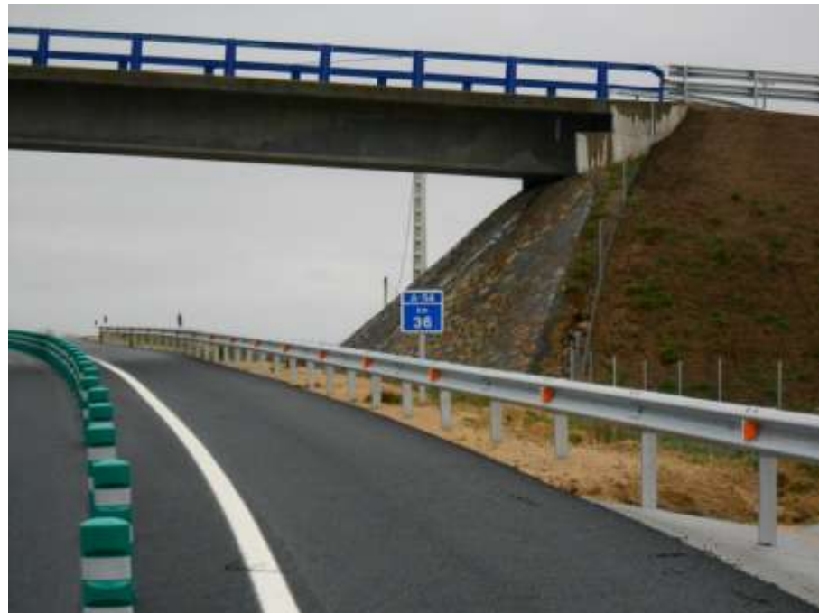
Foto 39: Margen derecha. Inicio carril deceleración.
