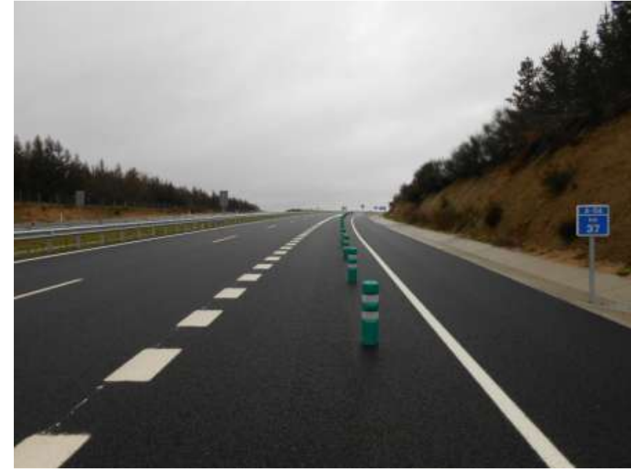
Foto 2: Margen izquierda. Carril deceleración P.K.37.
