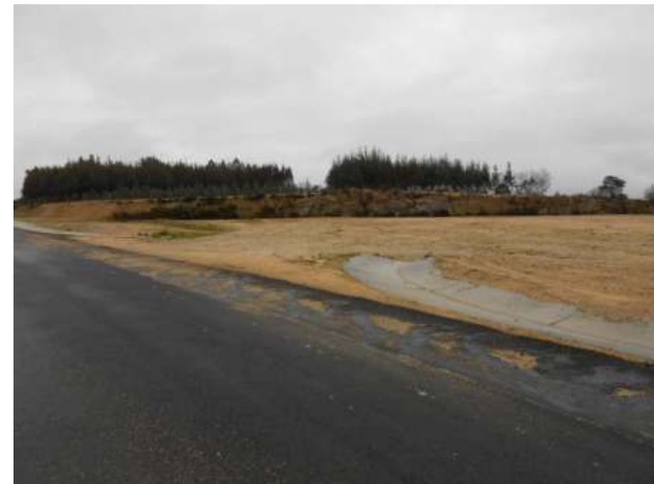
Foto 12: Margen izquierda. Zona de la entrada y salida proyectadas.
