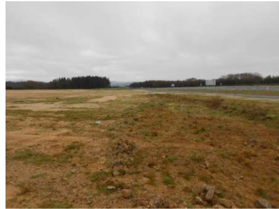
Foto 16: Margen izquierda. Explanación.
