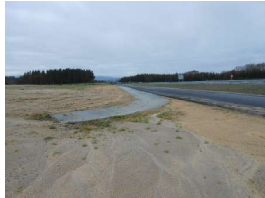
Foto 14: Margen izquierda. Zona de la entrada y salida proyectadas.
