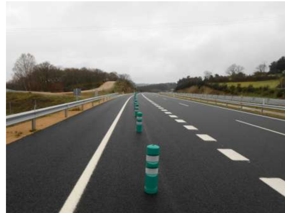
Foto 40: Margen derecha. Inicio carril deceleración.
