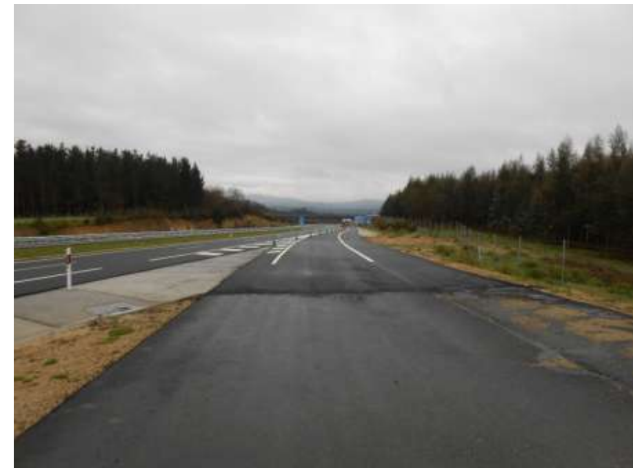
Foto 60: Margen derecha. Inicio carril aceleración.
