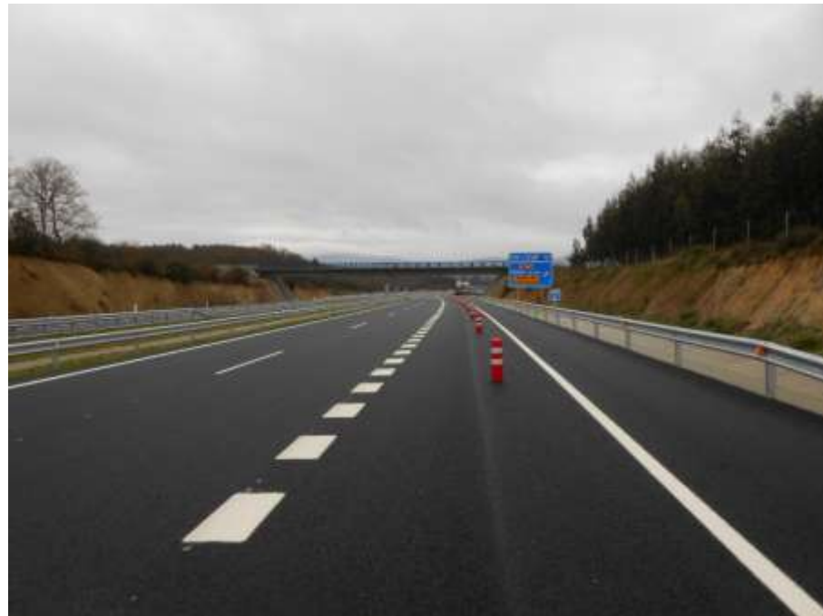
Foto 63: Margen derecha. Carril aceleración.
