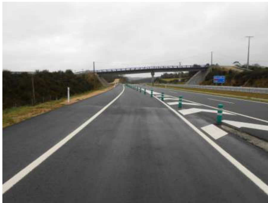
Foto 43: Margen derecha. Carril de acceso a la semiárea.
