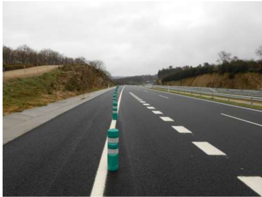
Foto 37: Margen derecha. Inicio carril deceleración.
