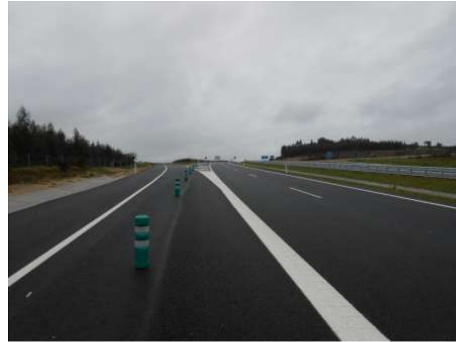
Foto 62: Margen derecha. Carril aceleración.
