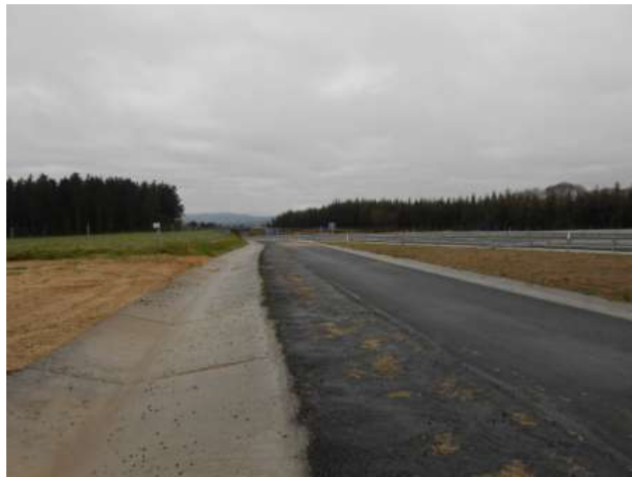
Foto 11: Margen izquierda. Vista carril y cuneta.
