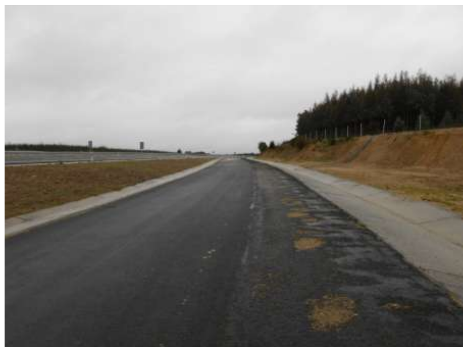
Foto 21: Margen izquierda. Carril de salida.
