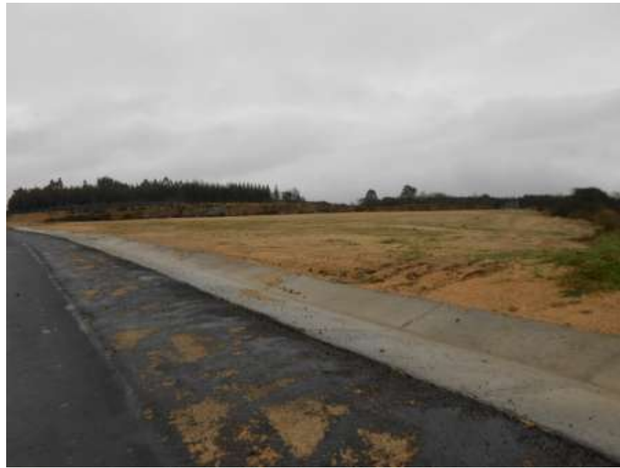
Foto 9: Margen izquierda. Ramal de acceso a la semiárea y cuneta.
