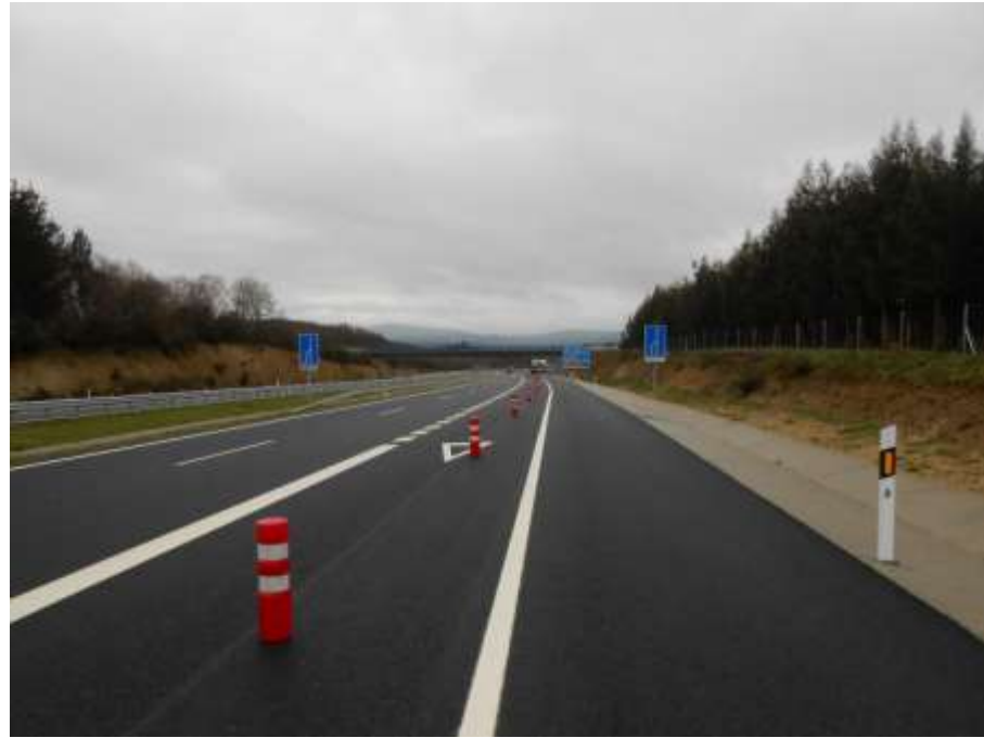
Foto 61: Margen derecha. Carril aceleración.
