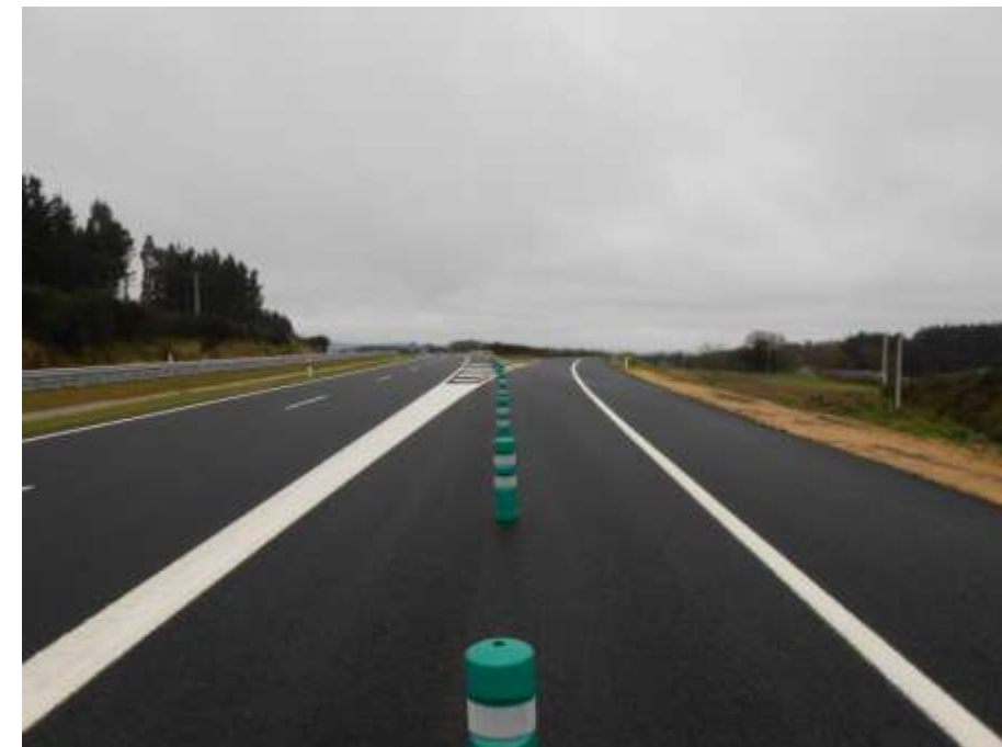
Foto 44: Margen derecha. Carril de acceso a la semiárea.
