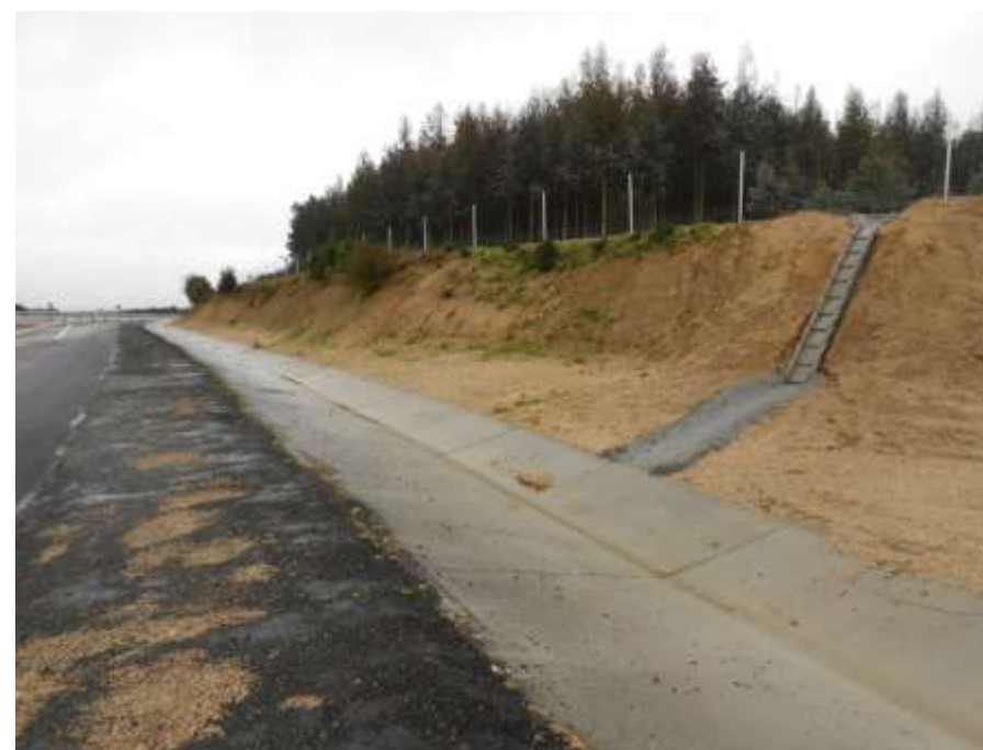
Foto 22: Margen izquierda. Detalle de bajante.
