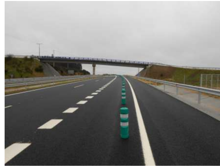
Foto 38: Margen derecha. Inicio carril deceleración.
