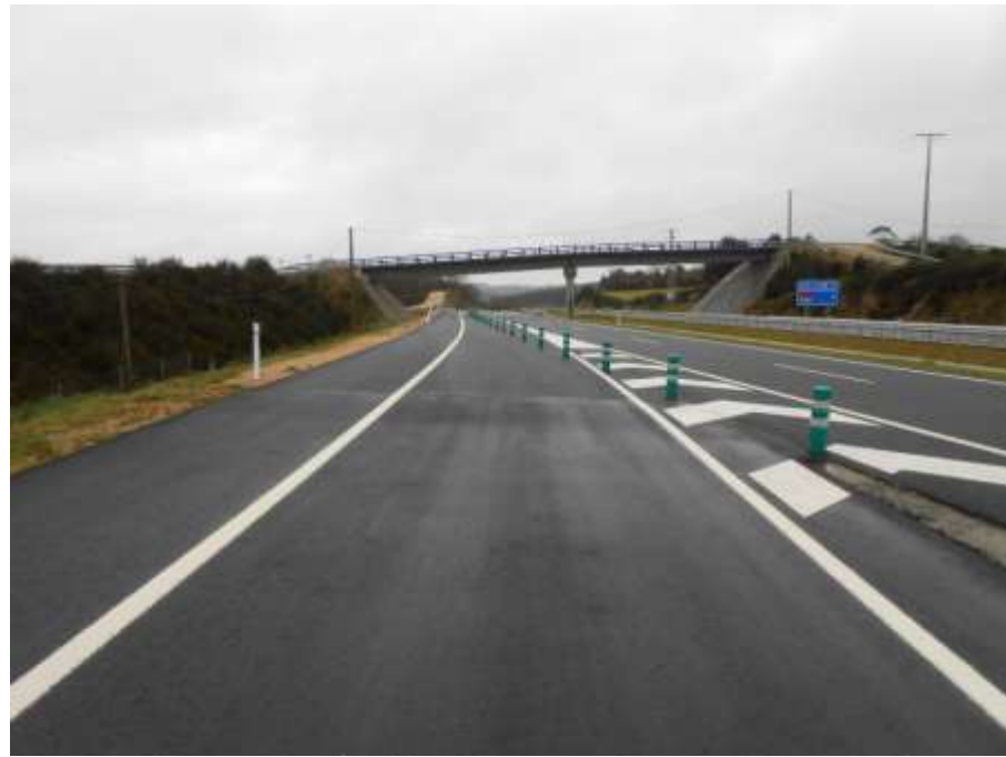
Foto 45: Margen derecha. Carril de acceso a la semiárea.
