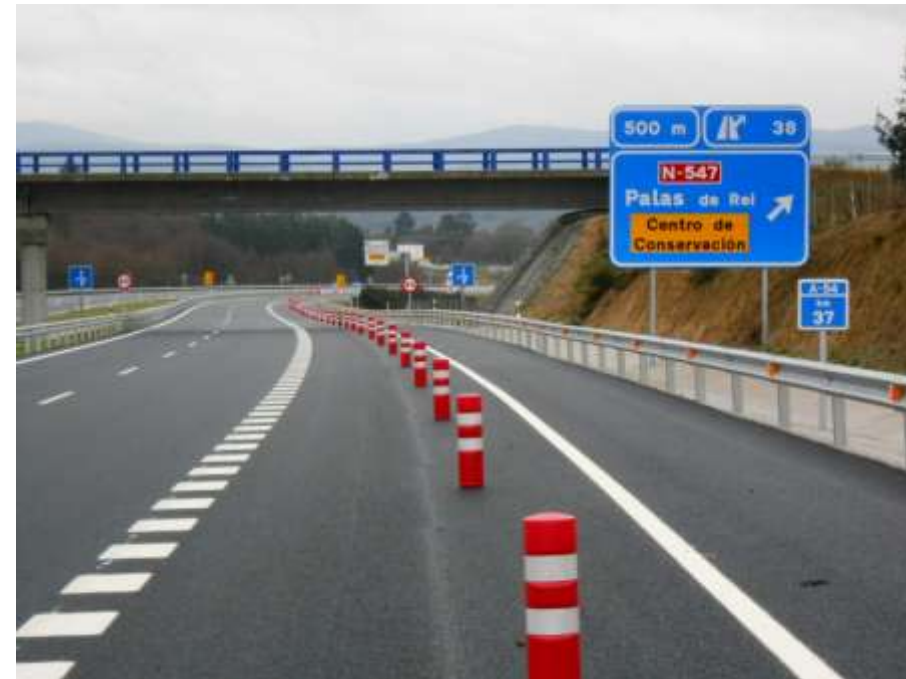
Foto 64 Margen derecha. Carril aceleración.
