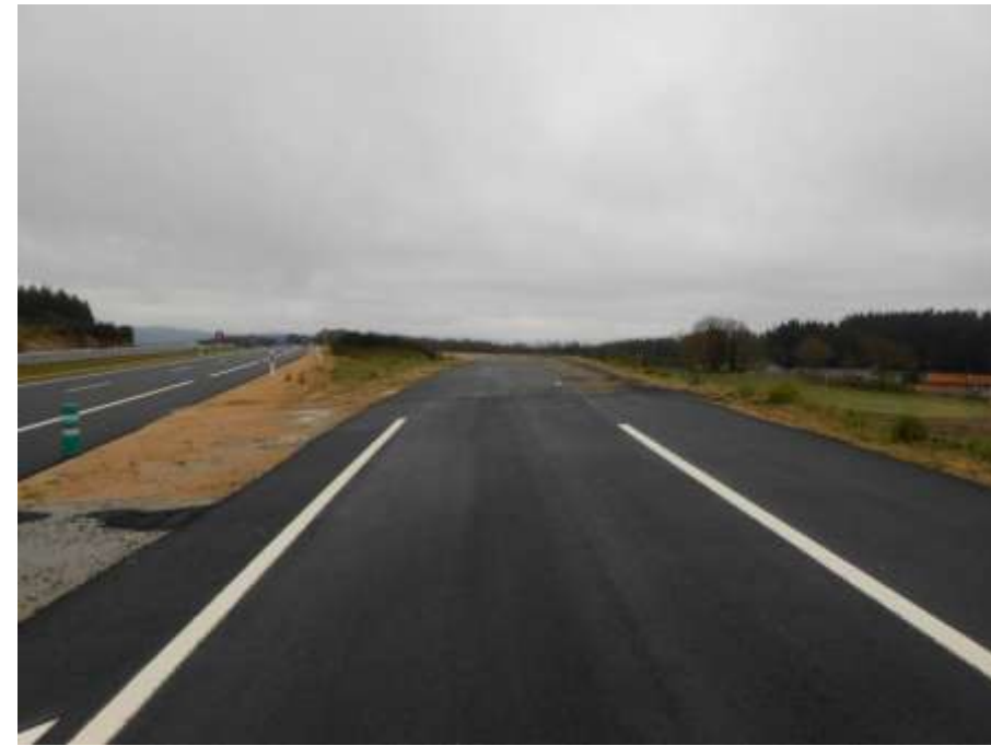
Foto 46: Margen derecha. Carril de acceso a la semiárea.
