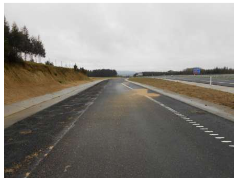
Foto 24: Margen izquierda. Carril de salida.
