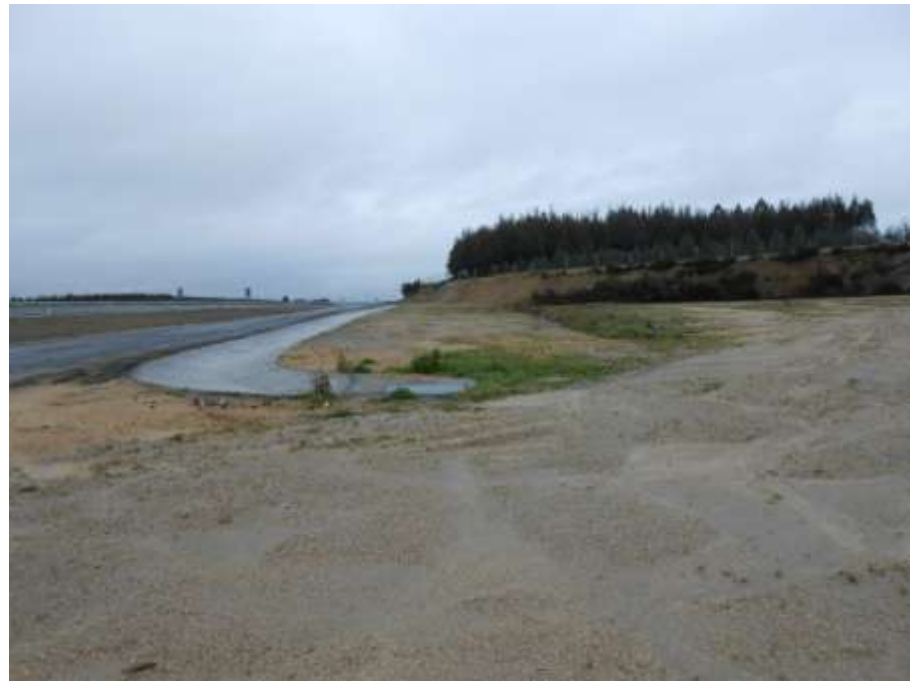
Foto 15: Margen izquierda. Zona de la entrada y salida proyectadas.
