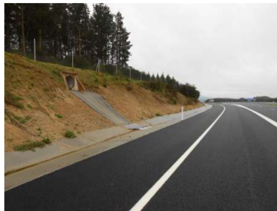
Foto 30: Margen izquierda. Carril aceleración y ODT.
