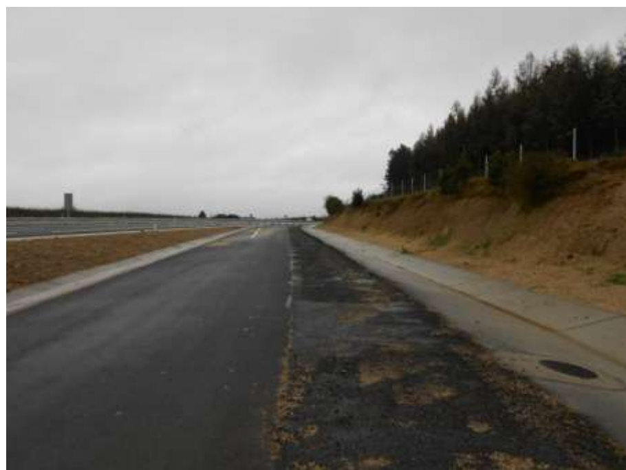
Foto 23: Margen izquierda. Detalle de pozo.
