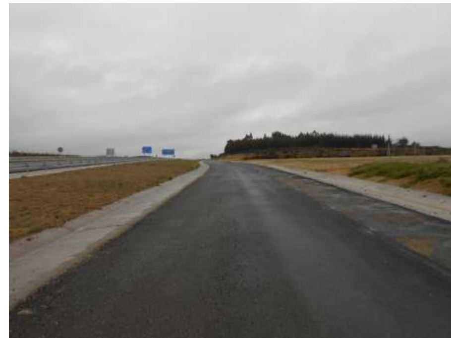
Foto 8: Margen izquierda. Ramal de acceso a la semiárea y cunetas.
