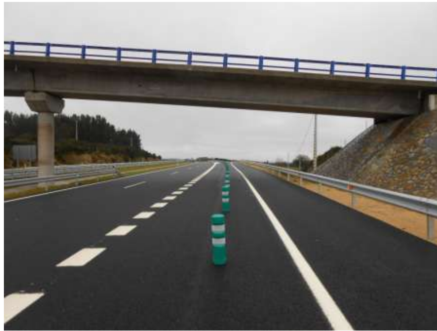
Foto 41: Margen derecha. Inicio carril deceleración.
