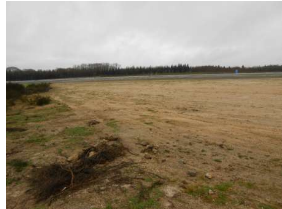
Foto 18: Margen izquierda. Explanación.
