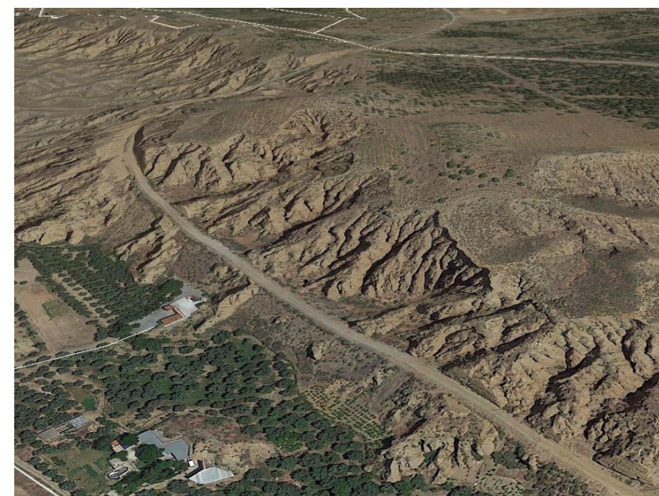
Figura 41. Rampa de subida desde la estación de Guadix
