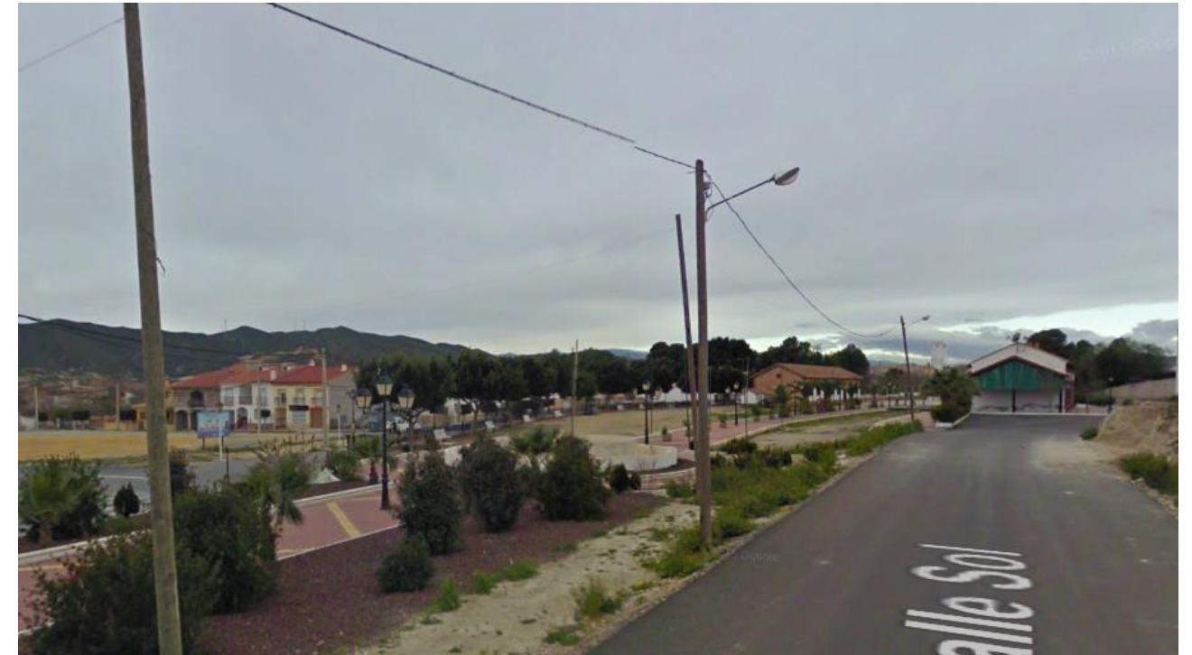
Figura 51. Estación de Zurgena
