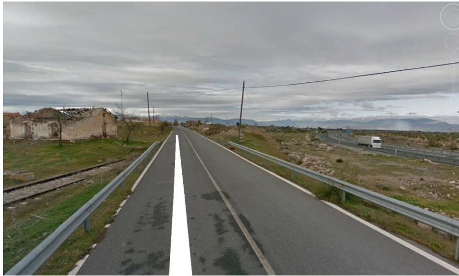
Figura 42. Paso a nivel en Hernán-Valle. A la derecha, la autovía A92-N
