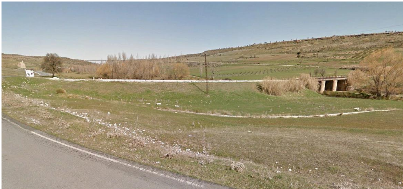
Figura 43. A la derecha, puente sobre el Río Gor. A la izquierda, viaducto de la A92-N sobre el mismo cauce
