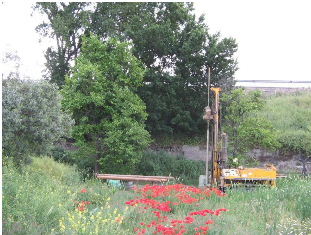
EXP. 13.083/09 EMPLAZAMIENTO SONDEO ROTATIVO S-2
