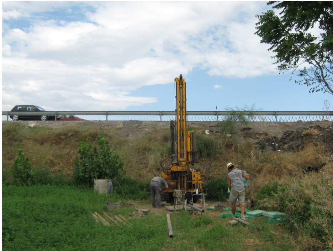
EXP. 13.083/09 EMPLAZAMIENTO SONDEO ROTATIVO S-1
