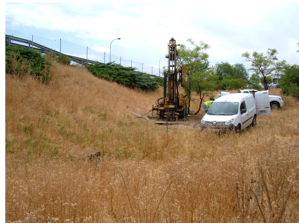
Figura 4. Emplazamiento del sonde S-6 realizado en la base del relleno antrópic compactado en la zona de la estructura E-1 (Eje 21).
