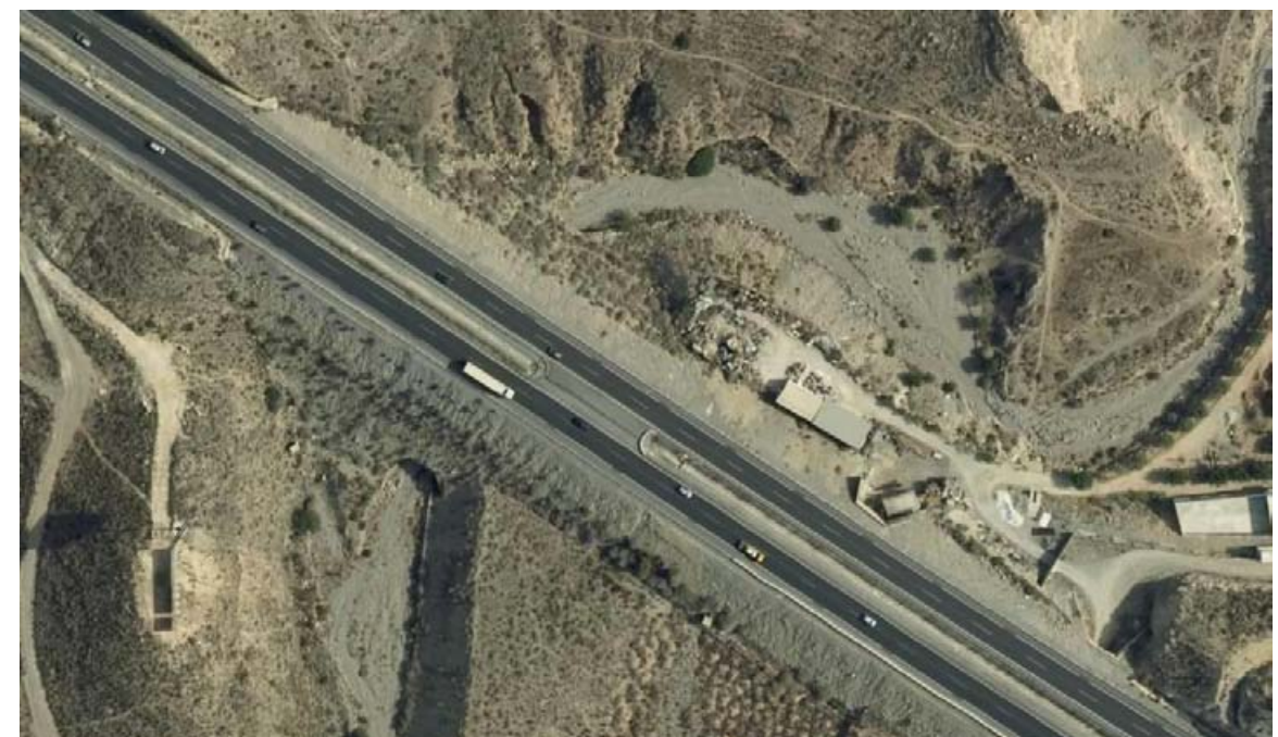
Cruce de mediana cercano a la boca Oeste del túnel de Aguadulce
