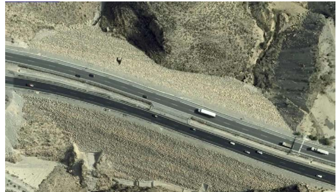
Cruce de mediana cercano a la boca Este del túnel de Aguadulce
