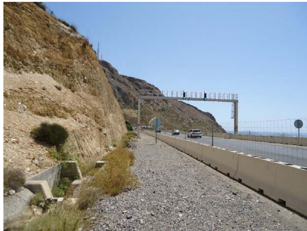
Berma de Calzada Sur a habilitar como zona de acceso y camino de operaciones durante las obras
