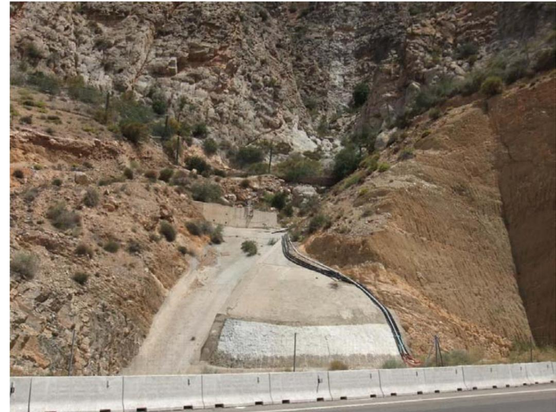
Imagen: Obra de drenaje trasversal del barranco del Polvorín que atraviesa actualmente la autovía A-7.
