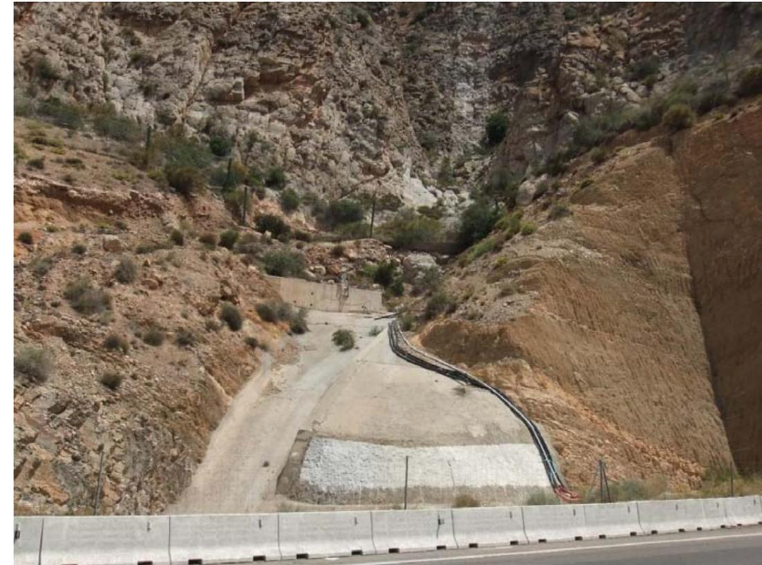
*Obra de drenaje transversal (ODT) existente en el cruce entre la Autovía A-7 y el Barranco del Polvorín.*
