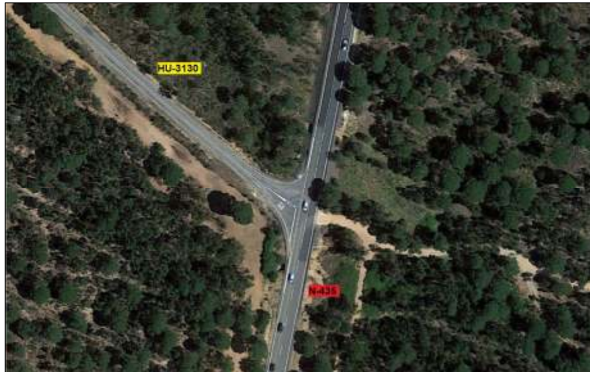
Ilustración nº 1: Intersección a nivel cruce Fuente la Corcha. Estado actual.
