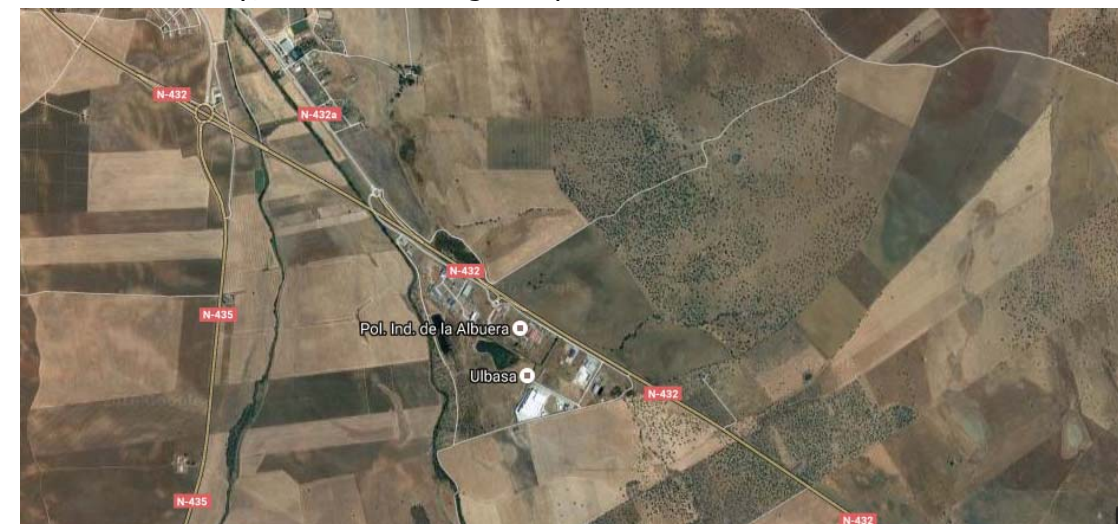
Zona de la futura intersección en el p.k. 26+132 M.D de la N-432
