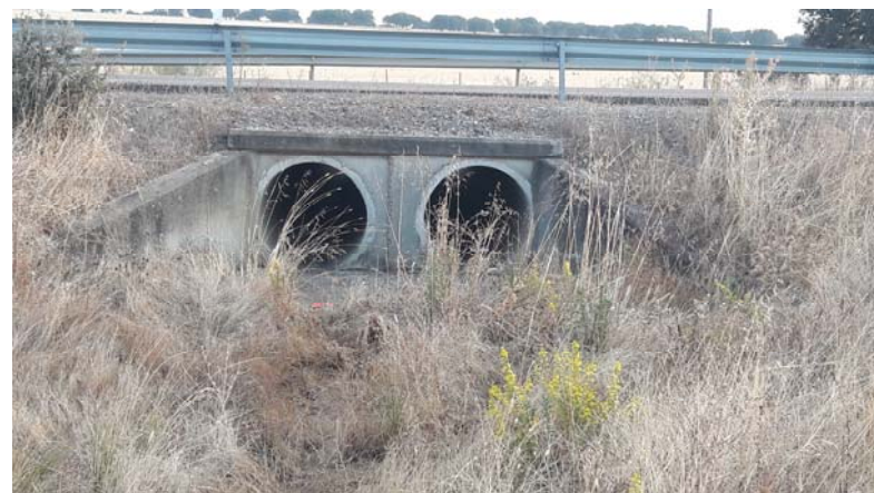
Obra de fábrica en la N-432 a ampliar
