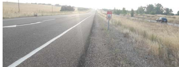
Foto tomada desde la futura intersección sentido Zafra
