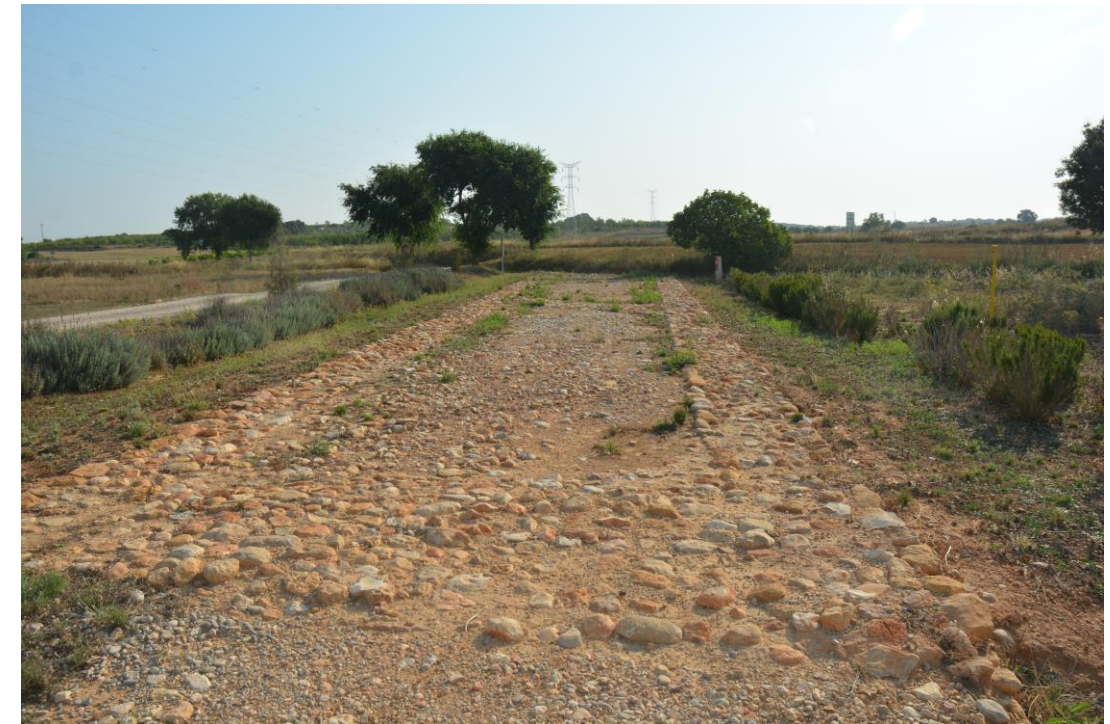
FOTO VÍA AUGUSTA: Actuación de recuperación de la vía augusta en el entorno de las obras.
