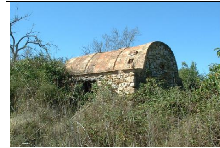
Elemento D5. P.K. 5+270. Caseta de Volta
