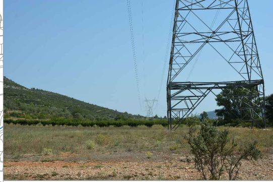
Sierra de la Solana y línea eléctrica de alta tensión
