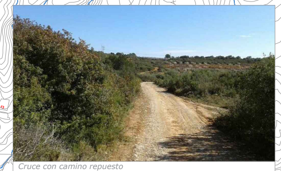
Cruce con camino repuesto
