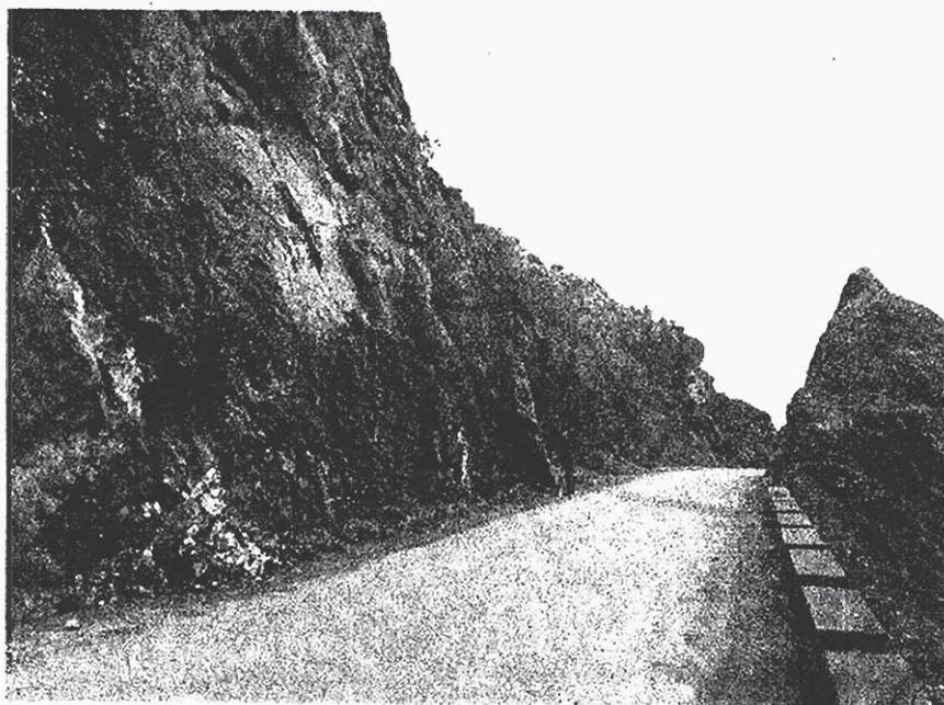
FOTO 4.- Desprendimientos de cierta consideración en el grupo B<sub>1</sub>. Zona de Anaga. Las flechas señalan los bloques caídos y la figura que da idea de proporción.
