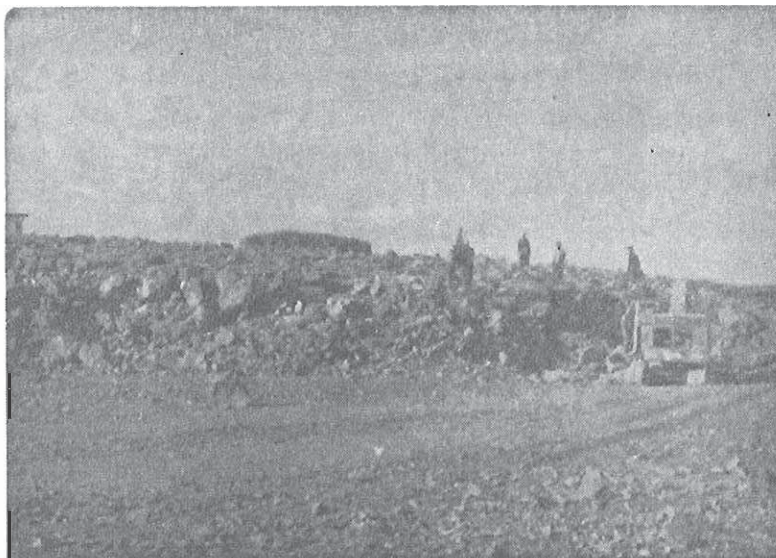
Carretera de Retamar Km. 150 de la C.N. 420
