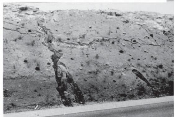
**Fotografía 4.4. Taludes inestables en la N-III Km 78 y próximos.**
