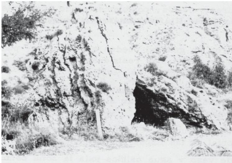
*Fotografía 3.6. Desprendimientos de bloques por disolución en fisuras de margas yesíferas en el km 4 de la carretera a Tielmes.*
