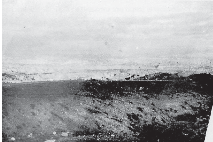
Terraplen construido con materiales de la formación de Guadix en la Carretera de Bator-Olivar
