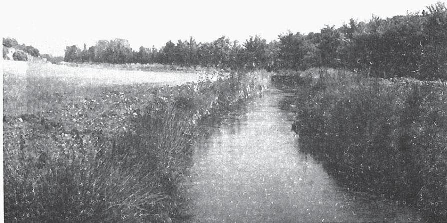
Fotografía 14. Río Zánacara al norte de La Alberca. La reexcavación del cauce ayuda al drenaje del valle bajo el nivel freático.
