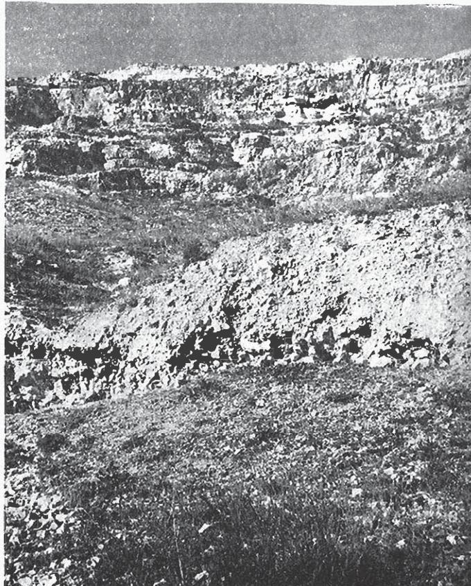
Fotografía 23. Talud rocoso en el anticlinal de El Cañavate. Se observa la inestabilidad del conjunto y el riesgo de desprendimientos de bloques de los estratos.
