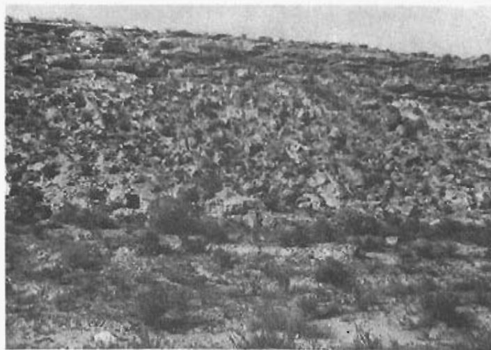
Foto 33.—Caída de bloques de las areniscas al quedar descalzadas por la erosión de las margas (materiales del grupo 32'c). (Cuadrante 820-2).
