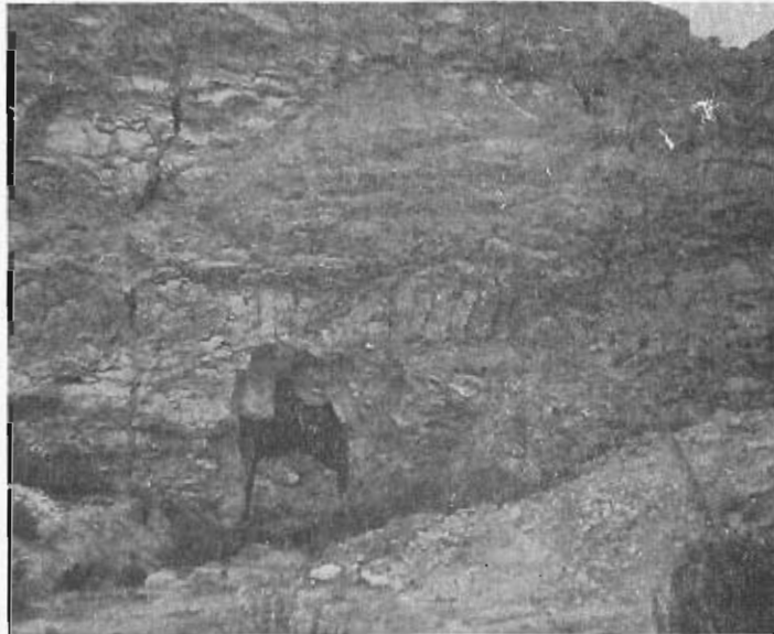
Foto 79.—Masa dolomítica muy diaclasada y fuertemente impregnada de yesos. Pese a su intensa trituración la cementación producida por el yeso permite que se sostenga el pequeño túnel abierto para dar salida a las aguas de escorrentía. (Cuadrante 871—3).
