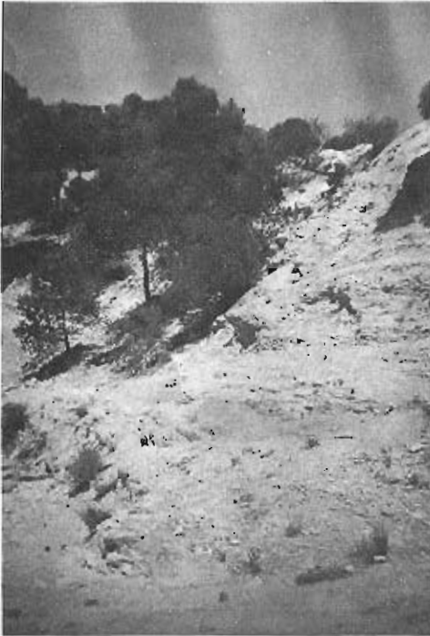
Foto 52.— Talud natural en las margas del grupo 32'g. (Cuadrante 870-1).
