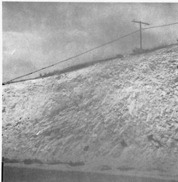
Foto 96.—Talud cortado en los materiales del grupo 26h (p.k. 5 de la C.L.A.—220). (Cuadrante 871—1).
