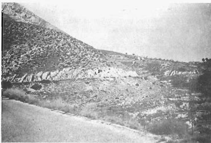
Foto 97.—Taludes de la C.L.A.P.—2122 cortados en los materiales del grupo 26h; el valle de la derecha se sitúa sobre las margas del grupo 26h'. (Cuadrante 846—2).
