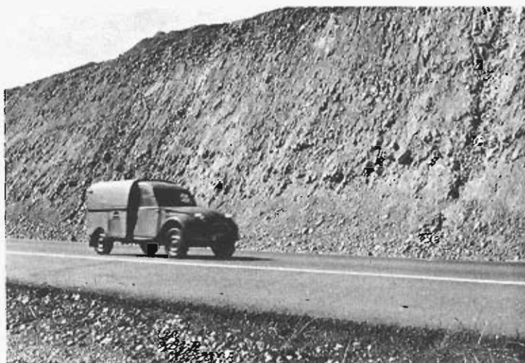
Foto 3-32 — Talud de la N-VI en materiales (32c).
