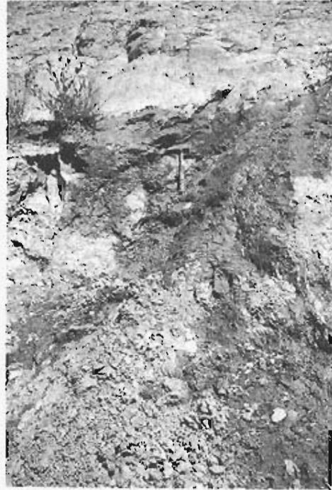
Foto 3-34 — Rezuma de agua a través de un nivel arenoso en un talud sobre el grupo 32a (vista general y detalle).
