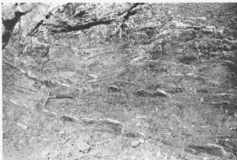
Foto 3-25 — Aspecto de los materiales del grupo (13a).
