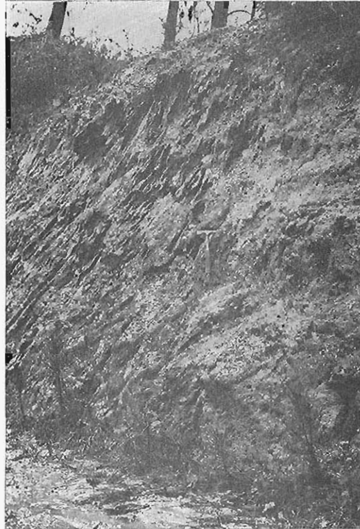
Foto 7. Detalle de un talud practicado en micaesquistos.
