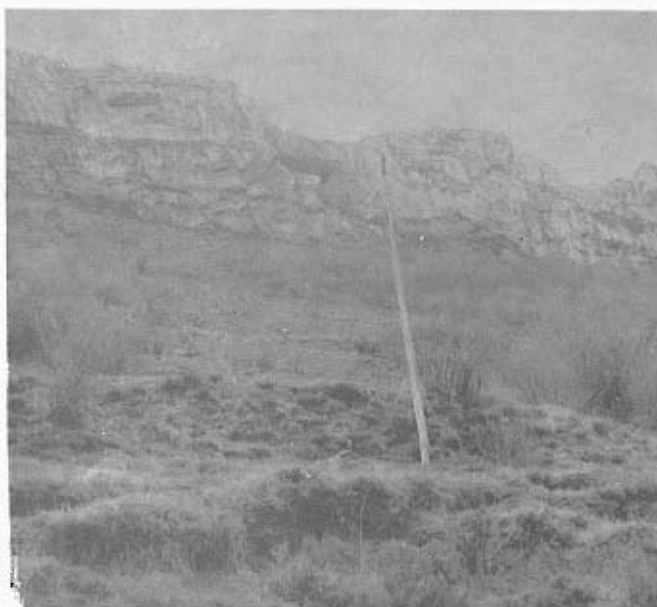
Foto 17.-- Suelos coluviales empapados (yacente margoso impermeable) que deslizan de forma natural. Obsérvese la inclinación del poste. (Cuadrante 109-4).
