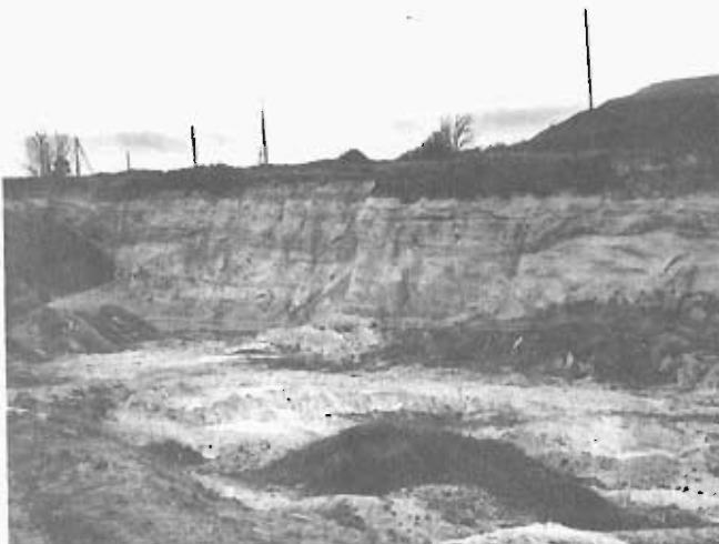
Foto 45.— Taludes de excavación en las arenas del grupo 231e con degradación lenta. (Cuadrante 134-4).
