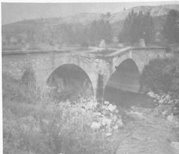
Foto 67.— Hundimiento de la pila central del puente del camino de las Mesas sobre el río Urbel, por disolución del yacente yesífero (Facies Keuper). (Cuadrante 167—1).
