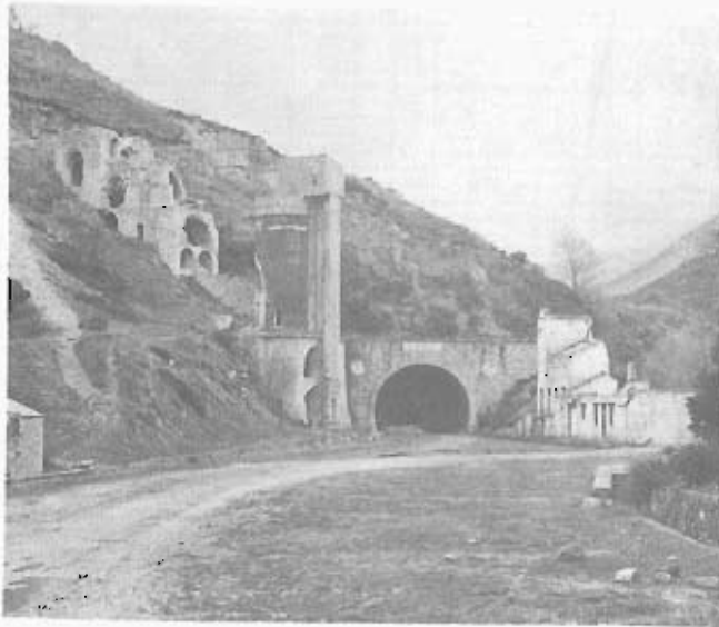
Foto 5.— Boca sur del Túnel de La Engaña, (ferrocarril Santander—Mediterráneo en construcción) abierto en los materiales de la Facies Wealdense. (Cuadrante 84—3).
