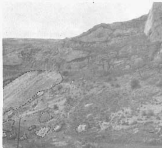
Foto 66.— Aludes de piedras y desprendimientos de las calizas cretácicas en las áreas de fracturación intensa. (Cuadrante 134—3)
