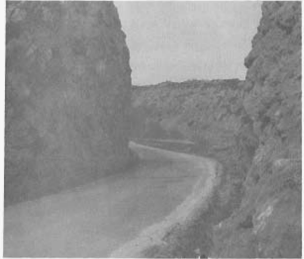
Foto 65.— Taludes verticales tallados en las calizas del grupo 232e. (Cuadrante 134—3).
