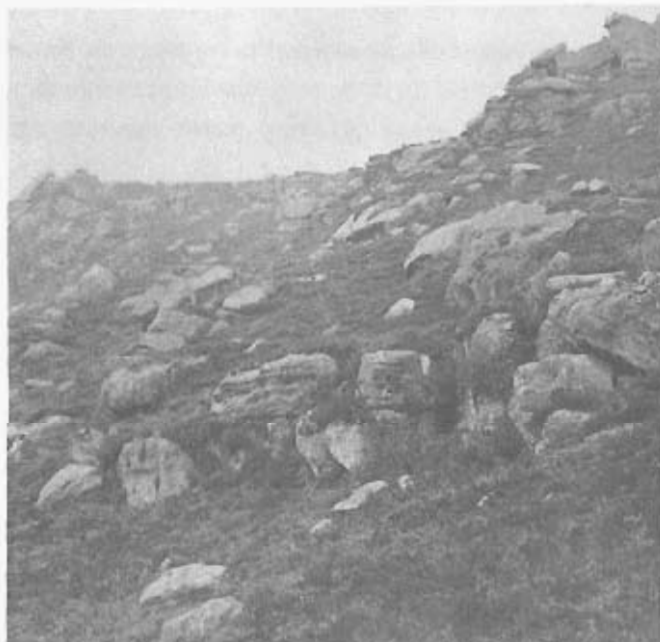
Foto 7.— Taludes con desprendimientos de algunos bloques en las areniscas del grupo 231f. (Cuadrante 84–3).
