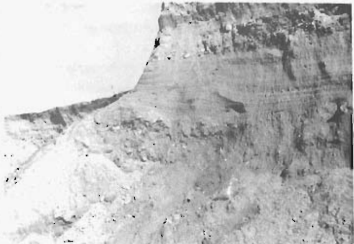
Foto 41.— Excavación para aprovechamiento de las arenas de los coluviales tipo C4. Obsérvese la degradación producida en el talud subvertical. (Cuadrante 134-4).
