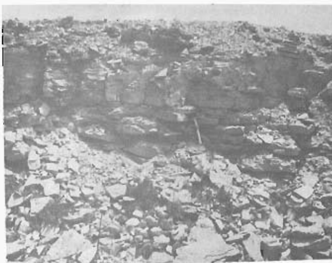
Foto 32.— Aspecto que ofrece un pequeño talud artificial excavado en el grupo 232b en el Páramo de La Lora. (Cuadrante 134–1).
