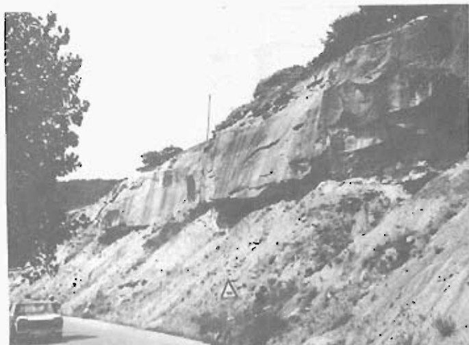
Foto 46.— Diferentes inclinaciones de equilibrio en los taludes del grupo 231a. (Cuadrante 134-3).
