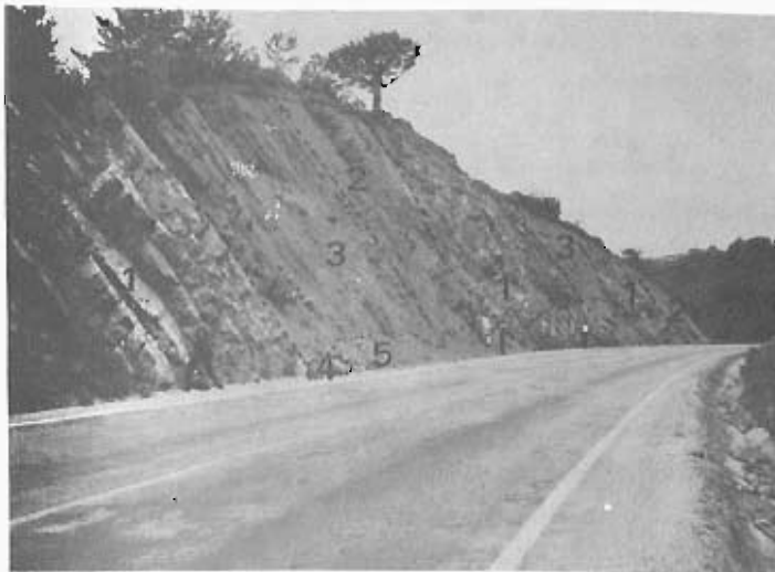
Foto 15.— Taludes excavados en los materiales del grupo 232a, N–623 1) Calizas, 2) Margas, 3) Areniscas, 4) Bloque desprendido, 5) Aterramientos de cunetas. (Cuadrante 109–3).
