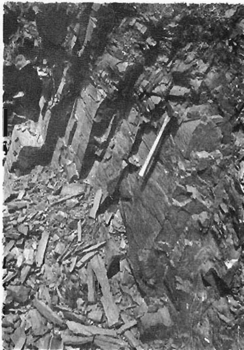
Foto 14 - Detalle del grupo 121 a. Se observa un marcado tableamiento.
