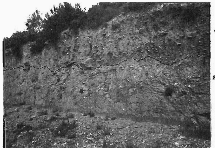
Foto 23 - Talud practicado en las pizarras del grupo 130 a. En la parte superior se observa un eluvial de potencia variable.
