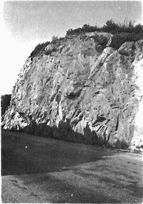
Foto 10 - Talud practicado en los granitos de dos micas inalterados.
