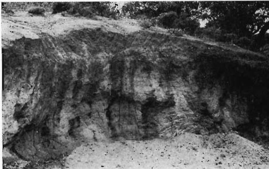
Fot. 17. Excavación en los niveles arenosos miocenos en las proximidades de la carretera de Torrejón el Rubio a Monroy. Se observan el talud inestable subvertical y un suelo suprayacente de pequeño espesor.
