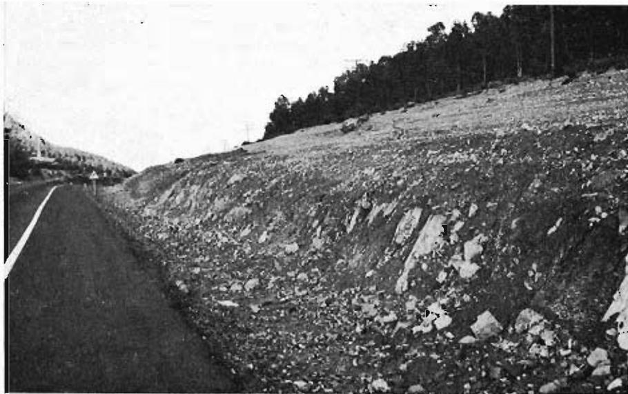
Fot. 23. Taludes en el coluvial en el P. K. 215 de la carretera N-V, Madrid-Badajoz. Obsérvese el distinto ángulo del talud natural y los taludes artificiales empleados.
