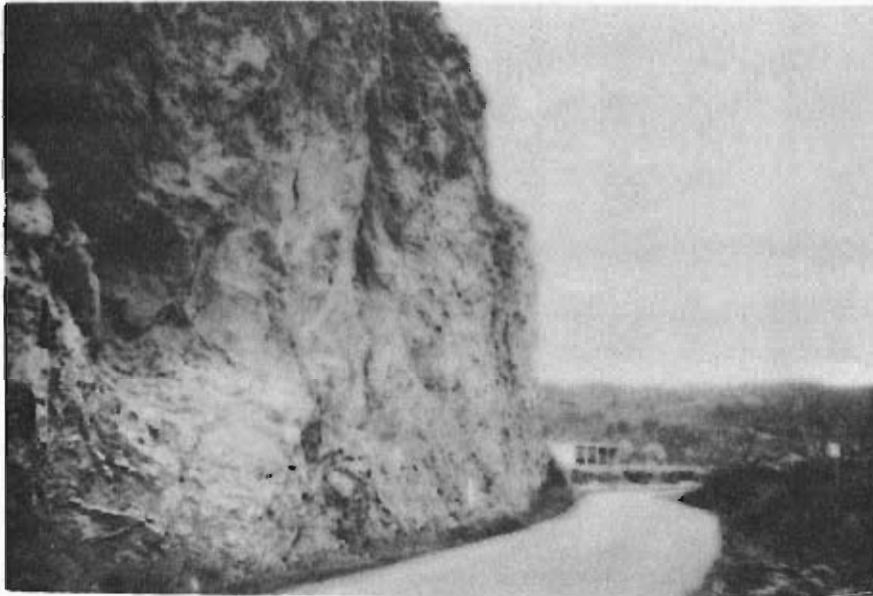
Foto 61.— Talud vertical en los yesos eocenos del grupo 312r2 [P.K. 7 de la Carretera C-1412 (Cuadrante 329-3)].
