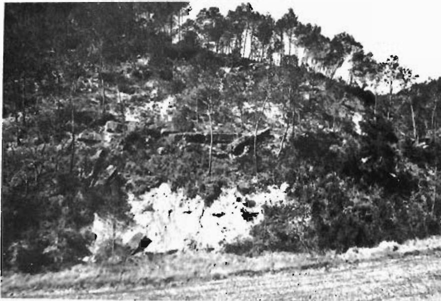
Foto 100.— Deslizamiento producido en las margas del grupo 312j1 con caída de un bloque de arenisca de la cornisa superior grupo 312j. (Cuadrante 362-2).
