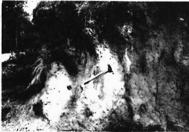
Foto 40.— Pequeño talud artificial en los materiales del grupo C2 (Cuadrante 329—1).
