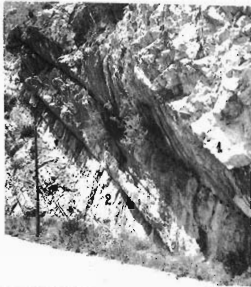
Foto 15.— Visera formada en el contacto entre los grupos 232c (1) y 232b (2), talud artificial verticalizado en la carretera C-1313, desfiladero de Oliana (Cuadrante 291-4).
