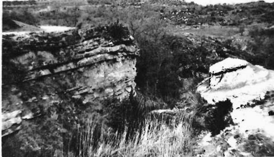
Foto 77.— Aspecto superficial de los taludes naturales del grupo 313g2 donde se distinguen los distintos tipos de materiales competentes e incompetentes frente a la erosión (Cuadrante 361-1).
