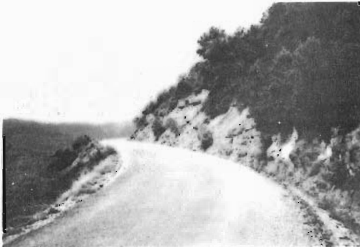
Foto.41.— Taludes artificiales tallados en el grupo 313i1, carretera C-140 (Cuadrante 320-1)
