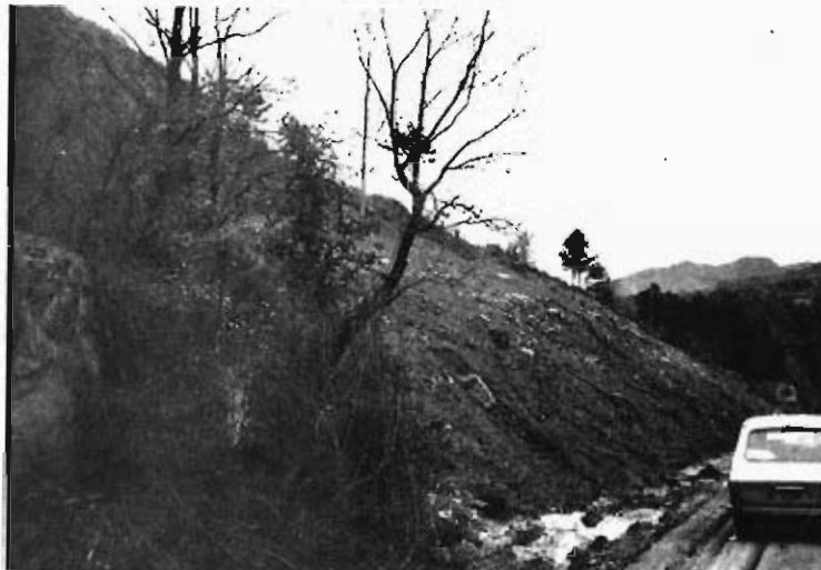
Foto 113.— Deslizamiento de coluviales arcillosos en el camino de Valmanya a Calaf. (Cuadrante 362-4).
