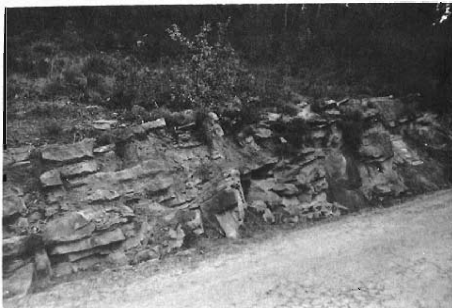
Foto 47.— Talud artificial en los materiales del grupo 313e1 (Cuadrante 330--3)
