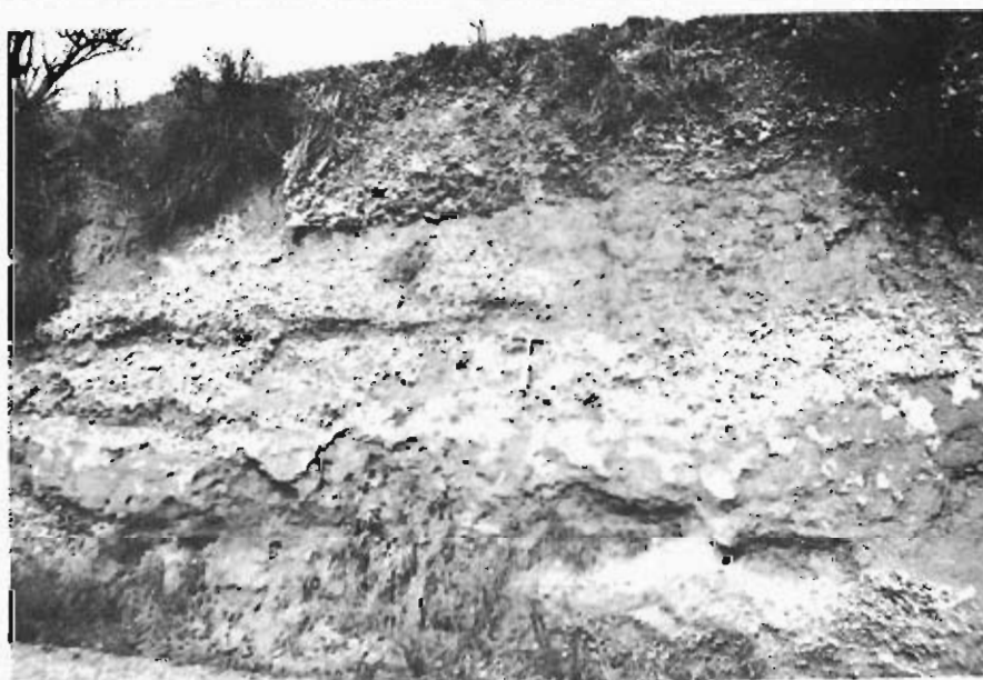
Foto 68.— Corte artificial en los suelos tipo A-2 en las proximidades de Iborra (Cuadrante 362-1)
