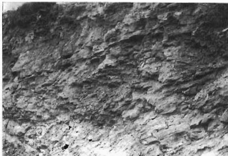
Fig. 55. Aspecto de detalle del talud natural, en el grupo 321a2, en la desviación de la C ra provincial de Níjar-Sorbas a Gafarillos.
