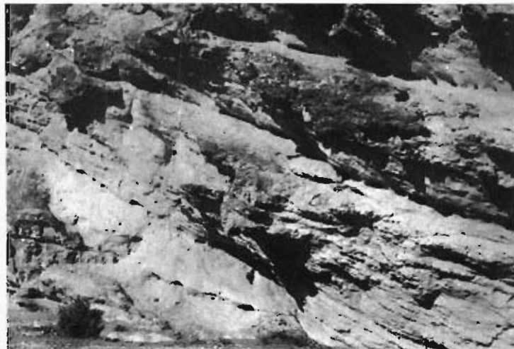
Fig. 37. Detalle del talud natural formado en el grupo 321a8 en la rambla de Lucáinena al sureste de la Cortijada de Polopos.
