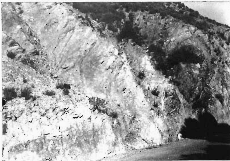
Fig. 15. Detalle del talud en el grupo 213a en la carretera de Hortichuelas a Felix.
