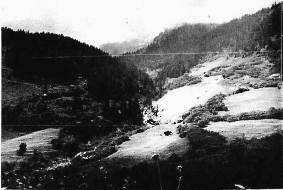
Foto 16.— El material extraído del túnel de Viella, acumulado en su salida norte. Sobre él, una caseta.
