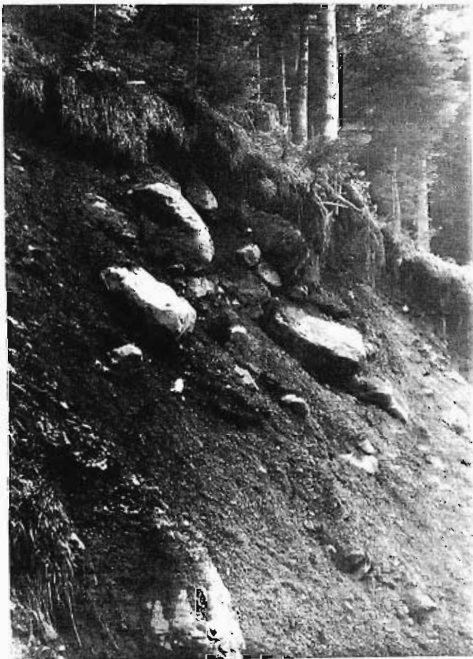
Foto 106.- Graves problemas de deslizamiento en los taludes de la carretera de acceso a Bonansa en el cruce con los materiales del grupo 211.
