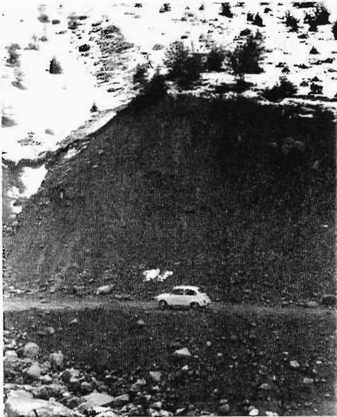
Foto 23.- Aspecto de los materiales del grupo C3 en un desmorte de gran altura situado en el barranco de las Coronas, al oeste de Plan.
