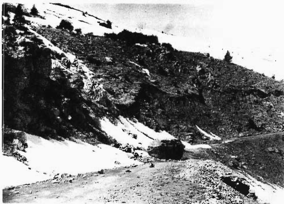
Foto 105. Pista cortada por desprendimiento de un gran bloque de caliza. Fotografía tomada en el camino de acceso al valle de Otal.
