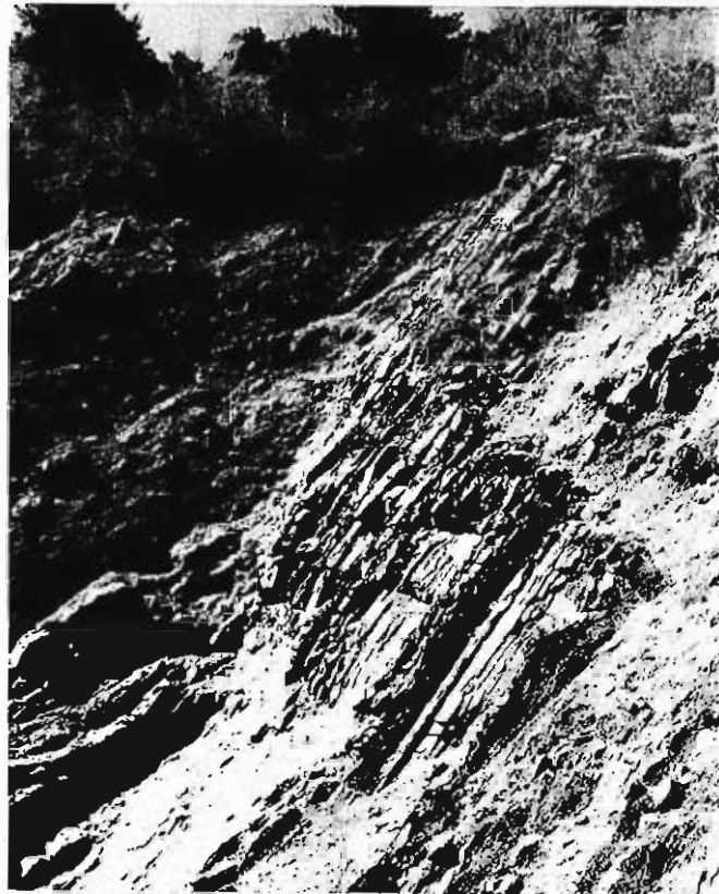
Foto 46.— Aspecto del grupo 221a a la entrada del túnel existente en la carretera de Bonansa.
