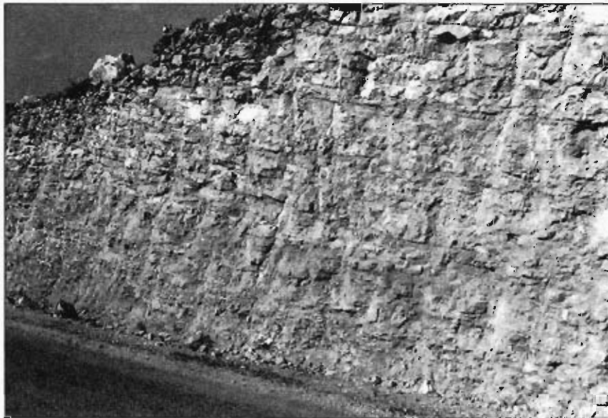
Foto 22.— Talud en calizas arenosas (321b) en Ituero.
