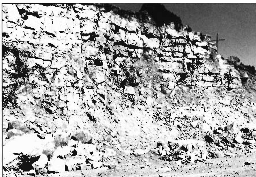
Foto 6.— Detalle de talud en el grupo 221a.
