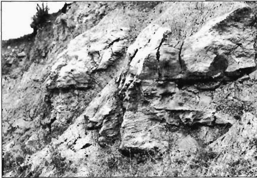
Foto 3.— Yesos masivos del Keuper (213) en el arroyo de Pradijón (área de Robledo).
