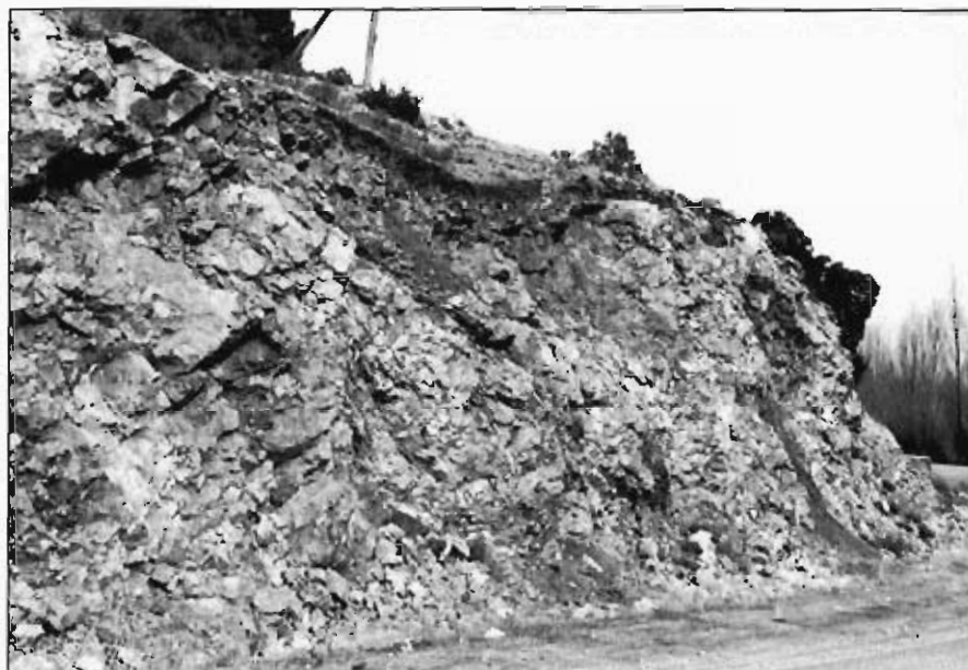
Foto 11.— Talud en el grupo 221c. Carretera Balazote-El Jardín.
