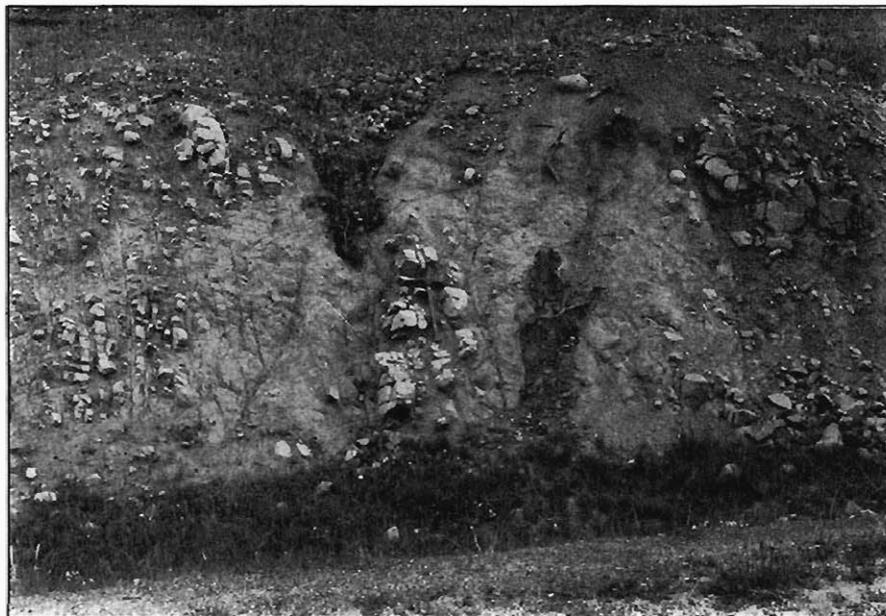
Fig. 3.61.— Diaclasas en las doleritas del grupo (150), muy alteradas. Talud de la carretera N-630, en las proximidades de Grimaldo.
