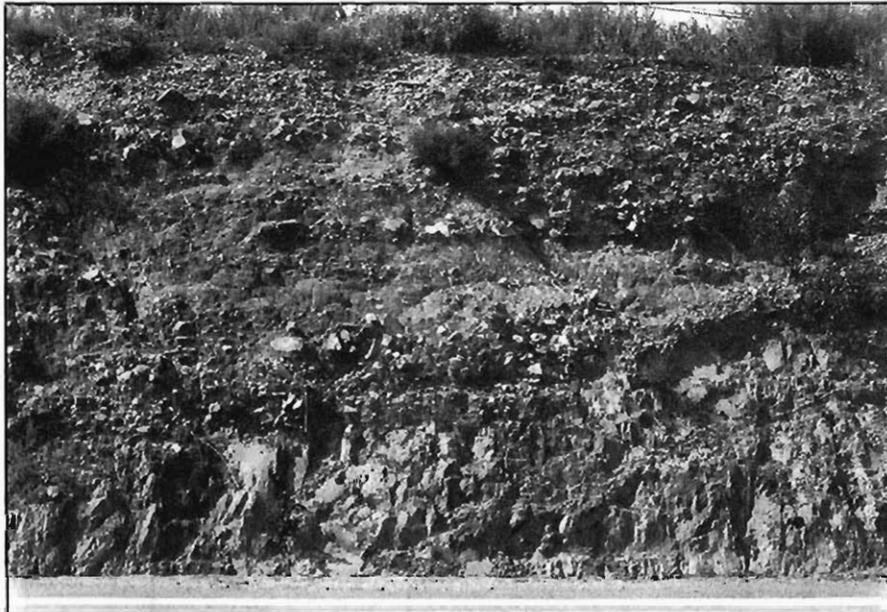
Fig. 3.23.— Aspecto del grupo (C1) en un talud de la carretera N-630. En la base aparece un esquisto grauváquico alterado.
