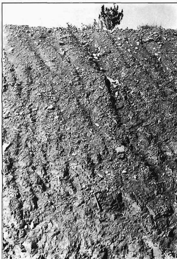
Fig. 3.30.— Parte superior de un talud ejecutado en el grupo (123). Las pizarras están muy alteradas y se disponen bajo suelos rojos que contienen cantos cuarcíticos.
