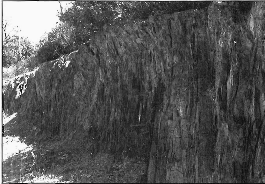
Figura 3.8.- Pequeño talud realizado en las pizarras y grauvacas del grupo (143a). Proximidades de la localidad de Gerena (Hoja 962-3).
