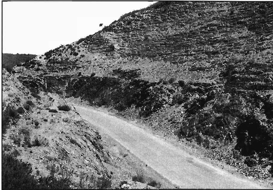
Figura 3.12.- Taludes realizados en las pizarras del grupo (143a). En primer plano, un talud de banco. Al fondo, un talud con dos inclinaciones, en función de la calidad de la roca. Obsérvese la acumulación de lajas al pie del mismo. Carretera de Aznalcóllar a El Castillo de las Guardas (P.K. 28) (Hoja 961-2).
