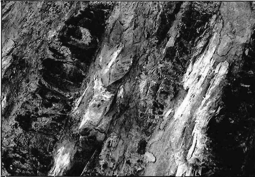
Figura 3.31.- Intercalaciones de limolitas y lutitas entre capas de cuarcita. Carretera N-620, P.K. 297,5 (Hoja 501-1).
