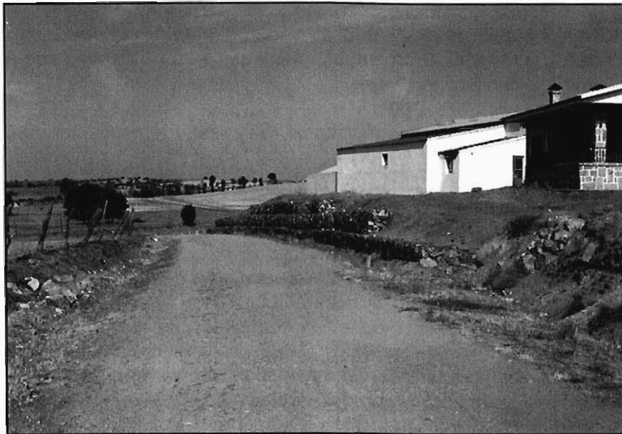
Figura 3.20.- Visión general de un terreno de litología metamórfica del grupo (111b). Se observa el horizonte de alteración superficial que tienen los materiales, en el que ha sido construido un muro de gaviones, para sujetar un pequeño talud realizado en el mismo.
