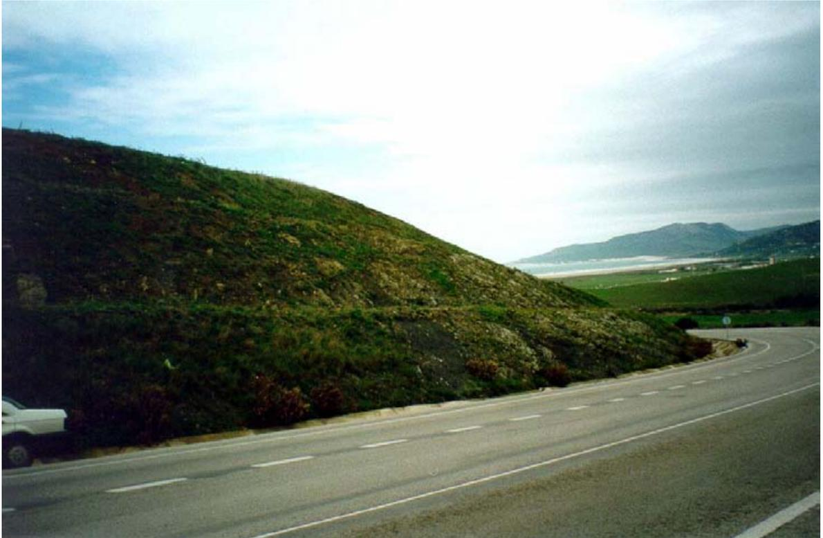
*Figura 3.65. Desmonte excavado en los materiales del grupo (313a), con dos bermas intermedias, situado en la variante de Tarifa de la N-340.*
