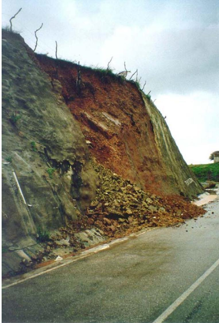
*Figura 3.66. Desprendimientos en un talud gunitado, excavado en los materiales del grupo (312f). Carretera local que bordea la costa de Algeciras a Punta Carnero (Hoja:1078-4).*
