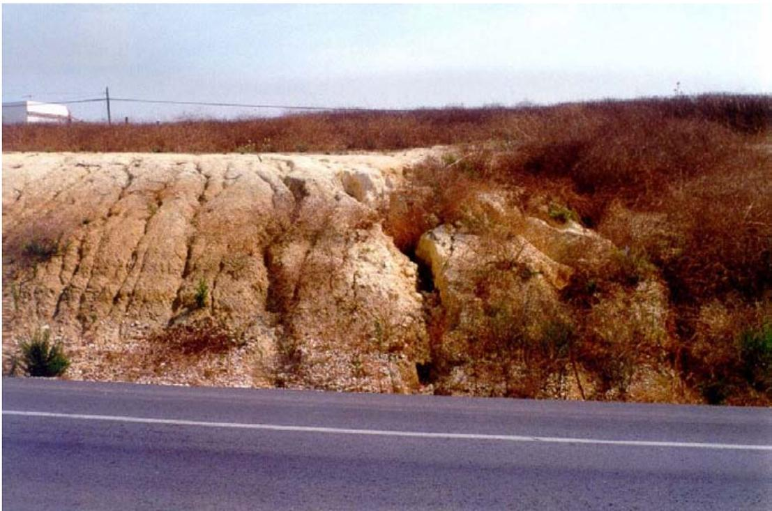
*Figura 3.21. Erosión en un talud excavado en las margas del grupo (321 g), localizado en el P.K. 21,500 de la carretera N-340.*
