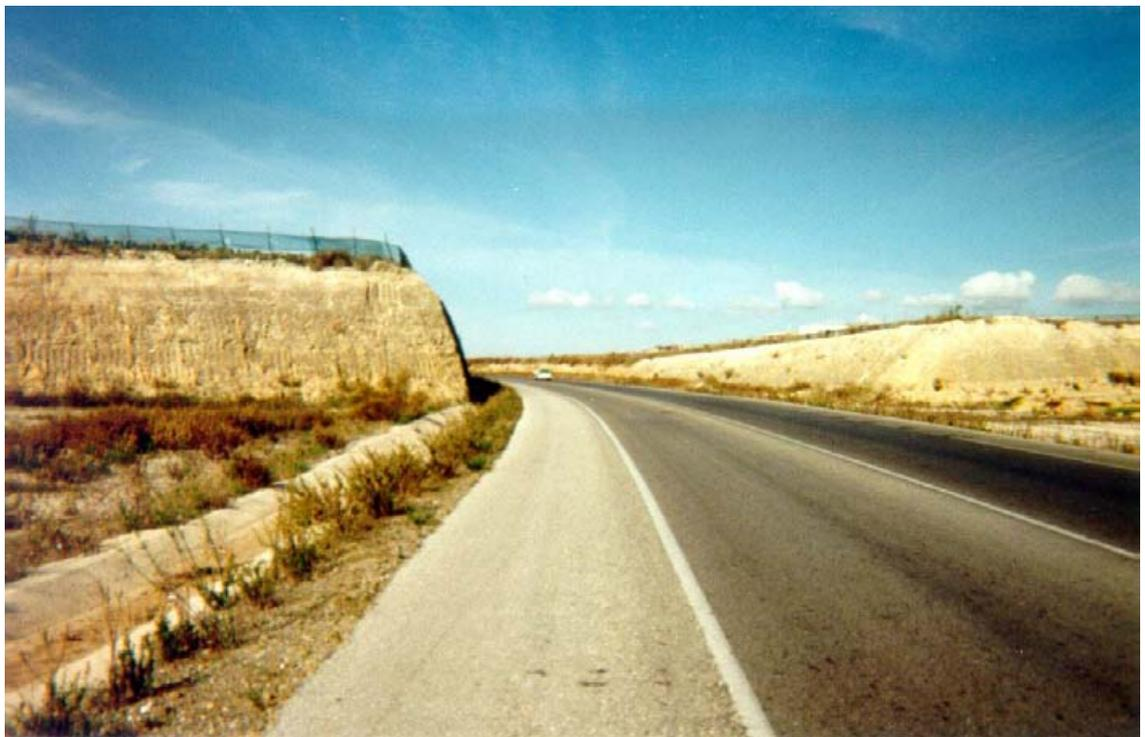
*Figura 3.17. Taludes de reciente excavación en los materiales de este grupo, en la variante de Chiclana. Los taludes son estables para pendientes fuertes.*
