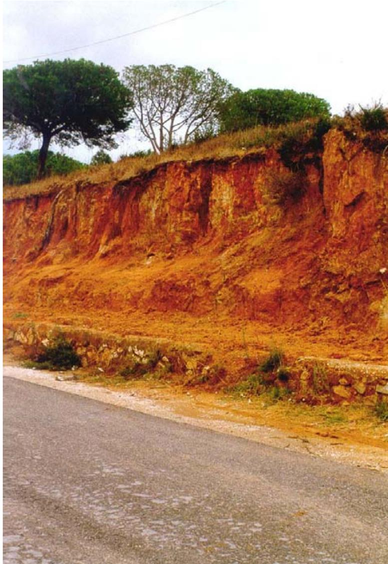
*Figura 3.14. Talud excavado en las arenas arcillosas del grupo (350b), en una carretera local al Norte de Chiclana. Obsérvese el pequeño muro de contención situado en la base.*
