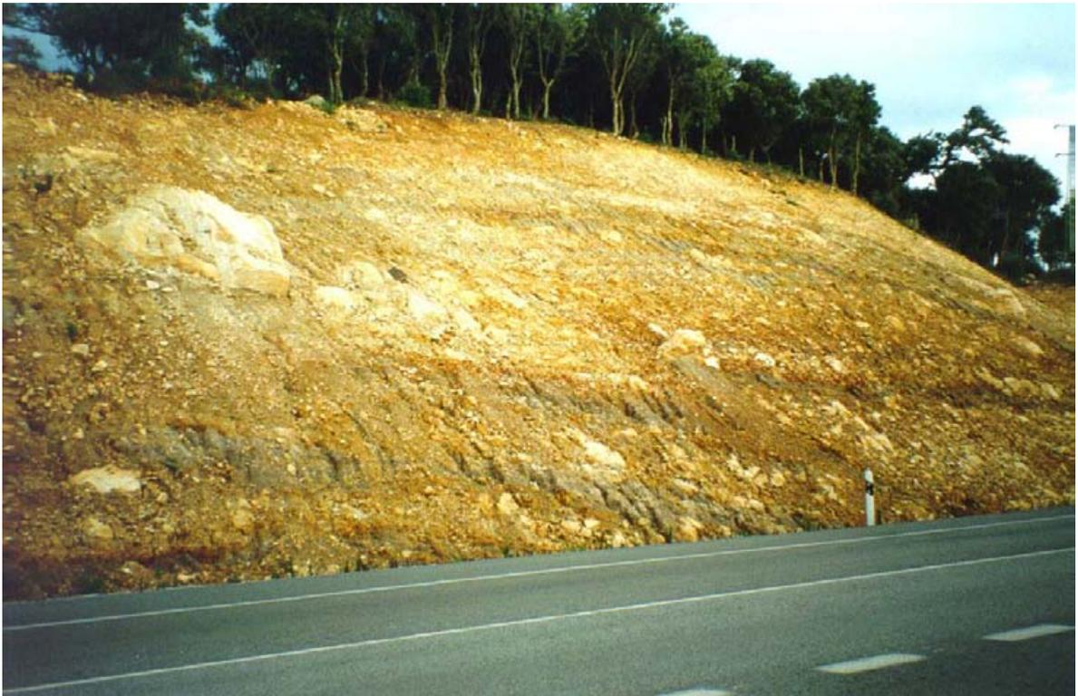
*Figura 3.56. Detalle, en corte, de los materiales del grupo (C2), en un desmonte de la carretera N-340, situado hacia el P.K.94,500. En la Figura puede apreciarse la estratificación gruesa que este grupo presenta en algunas zonas.*
