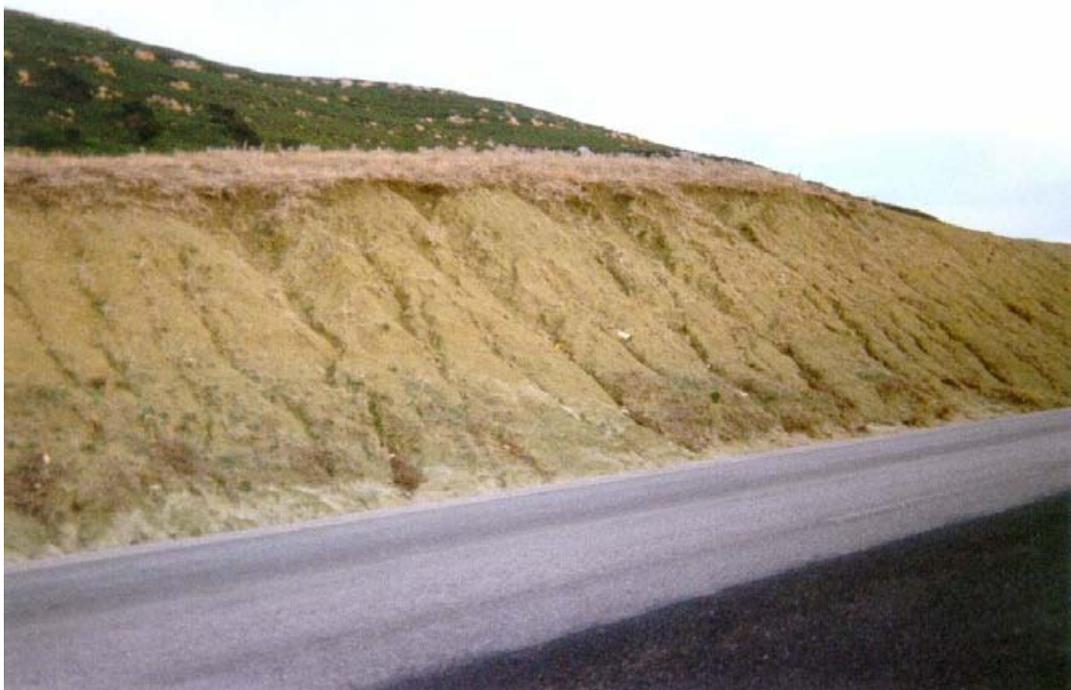
Figura 3.33. Erosión de las arcillas del grupo 321a, en un talud de la carretera de Zahara a Barbate.
