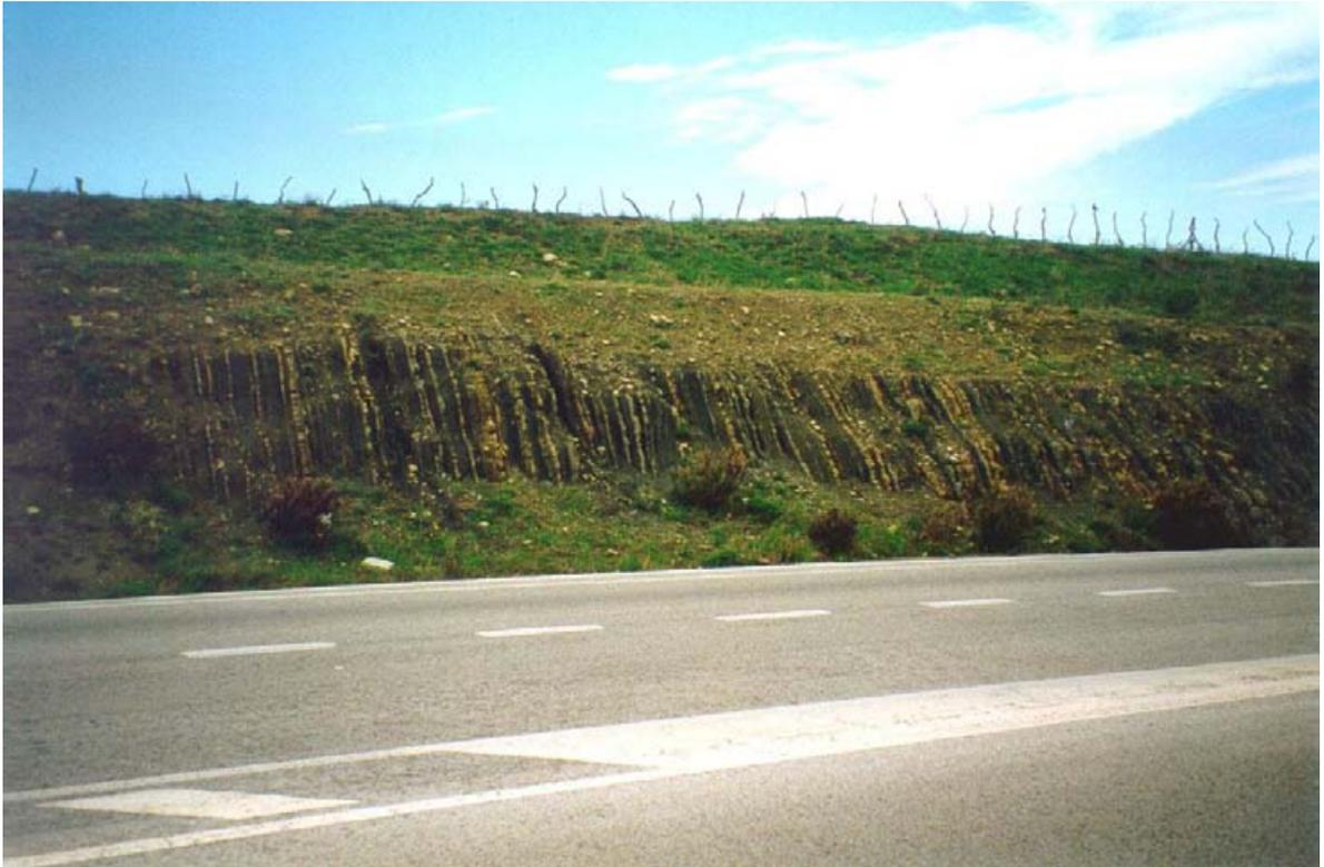
*Figura 3.70. Talud, con una berma intermedia, excavado en los materiales del grupo (311h), en la variante de Tarifa de la carretera N-340. Obsérvese el aspecto tipo flysch que presentan en este afloramiento.*
