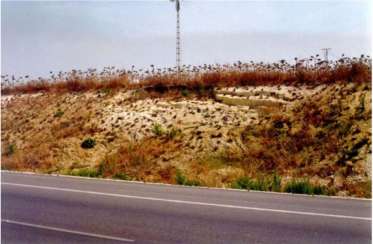
*Figura 3.22. Deslizamiento en masa en un talud de la carretera N-340, localizado hacia el P.K.21,450 y excavado en las margas azules del grupo (321g).*
