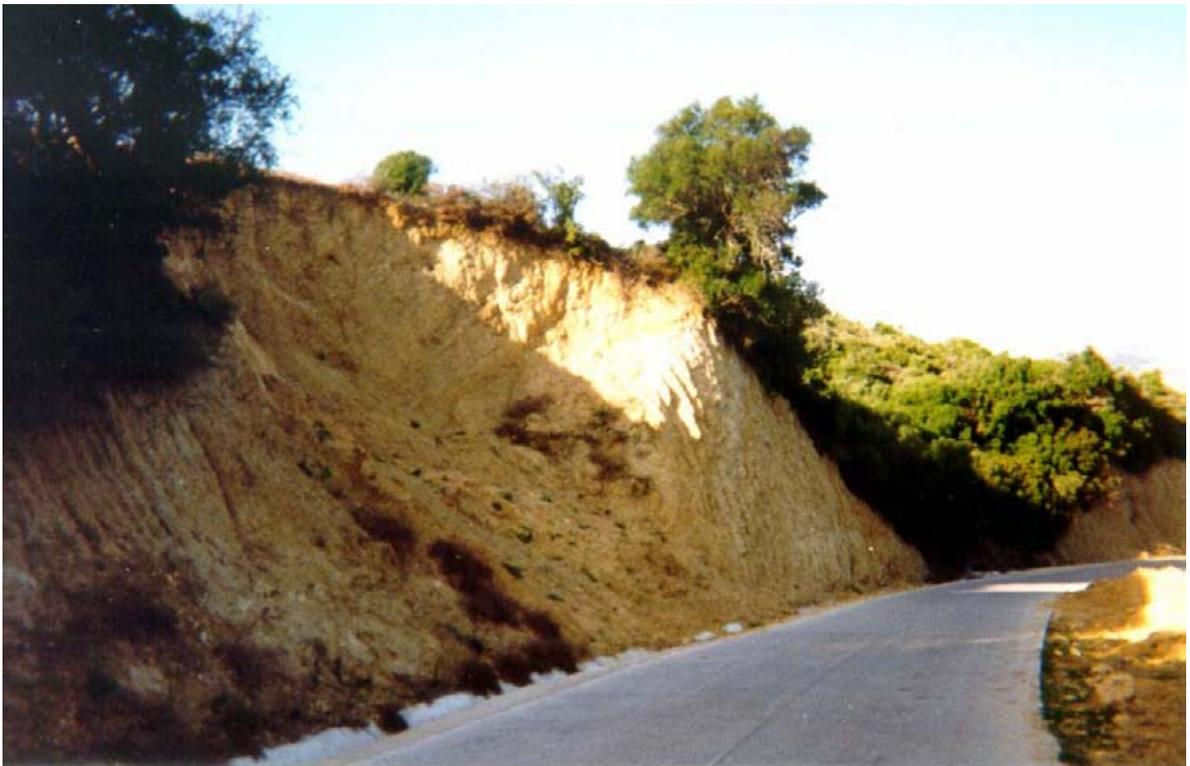
*Figura 3.58. Desprendimiento en un talud excavado en los materiales del grupo (321i). Camino asfaltado que sube a la Muela, por su lado Este.*
