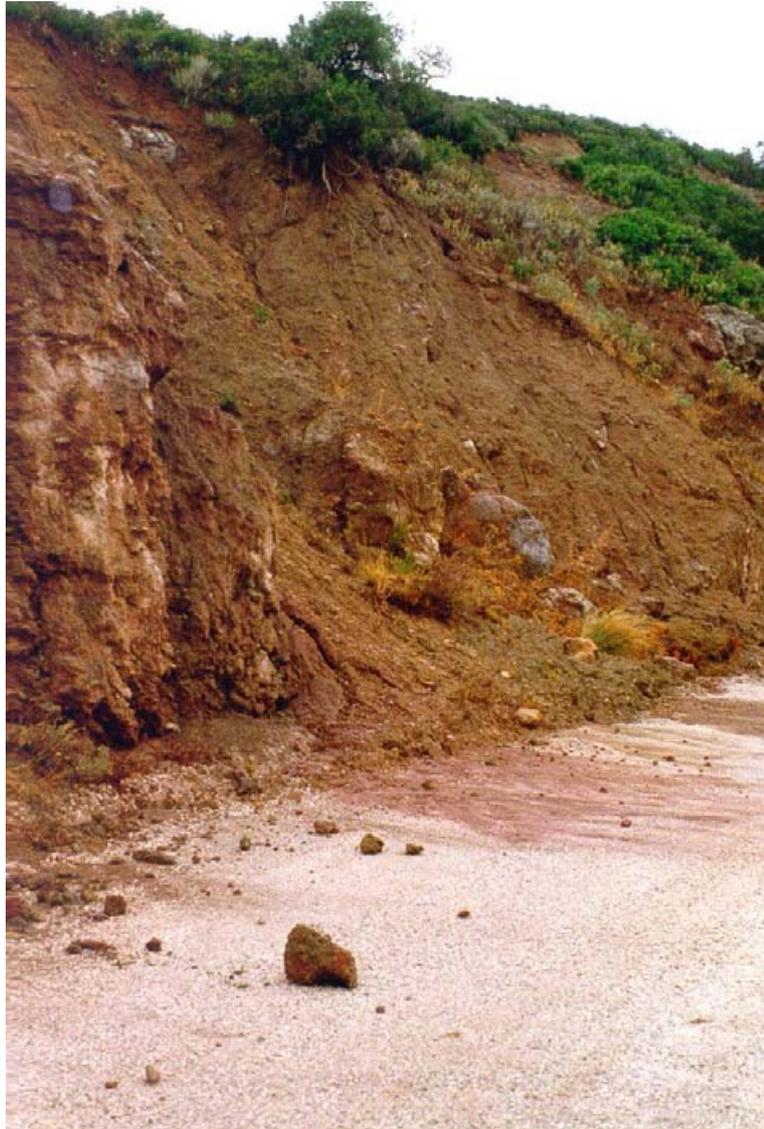
*Figura 3.49. Desprendimientos en un talud excavado en los materiales del grupo (213a), en la pista asfaltada de acceso a la cantera de El Berrueco (Hoja 1069-4).*
