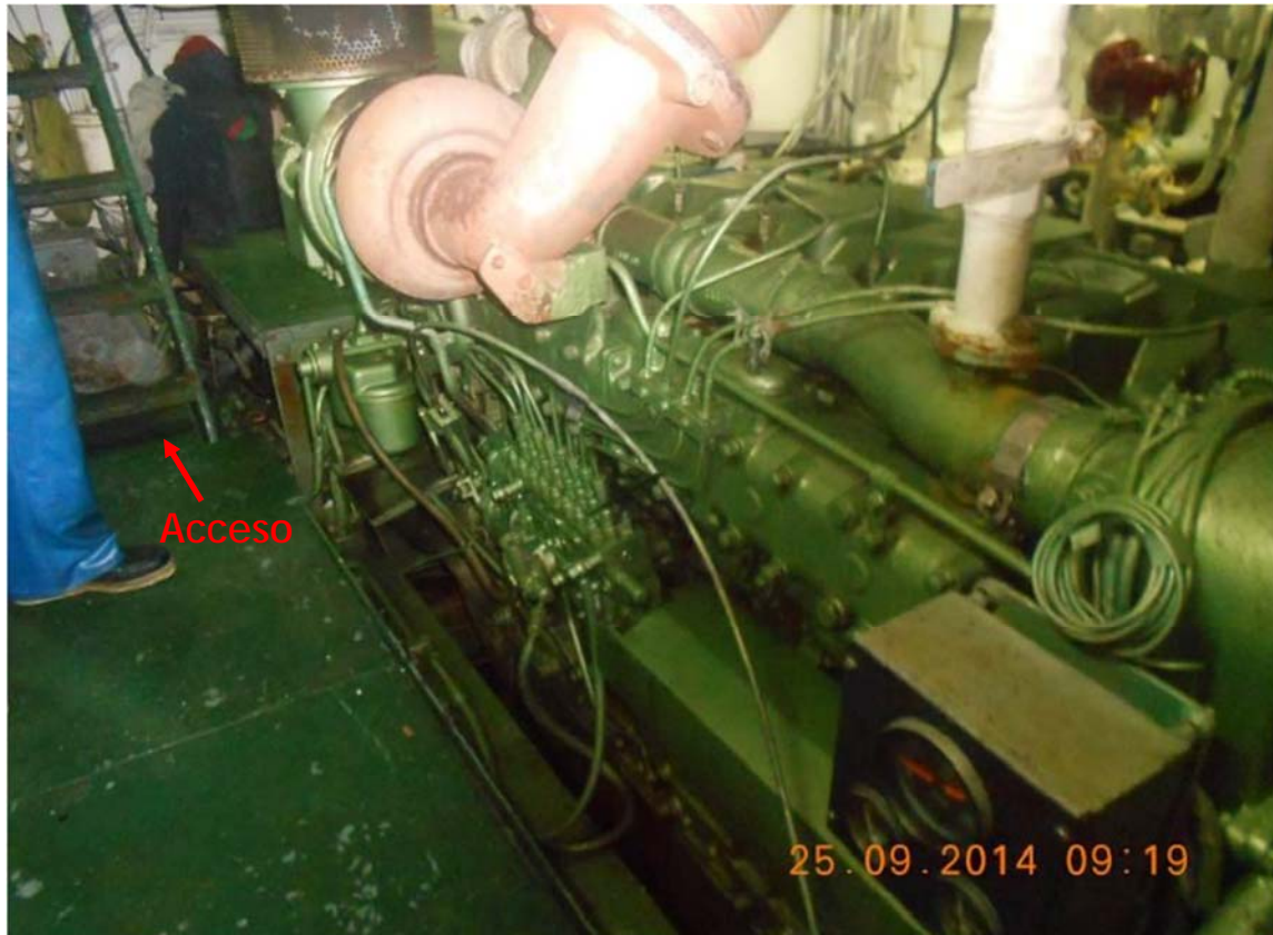
Figura 8. Acceso a cámara de máquinas situado en la banda de estribor
