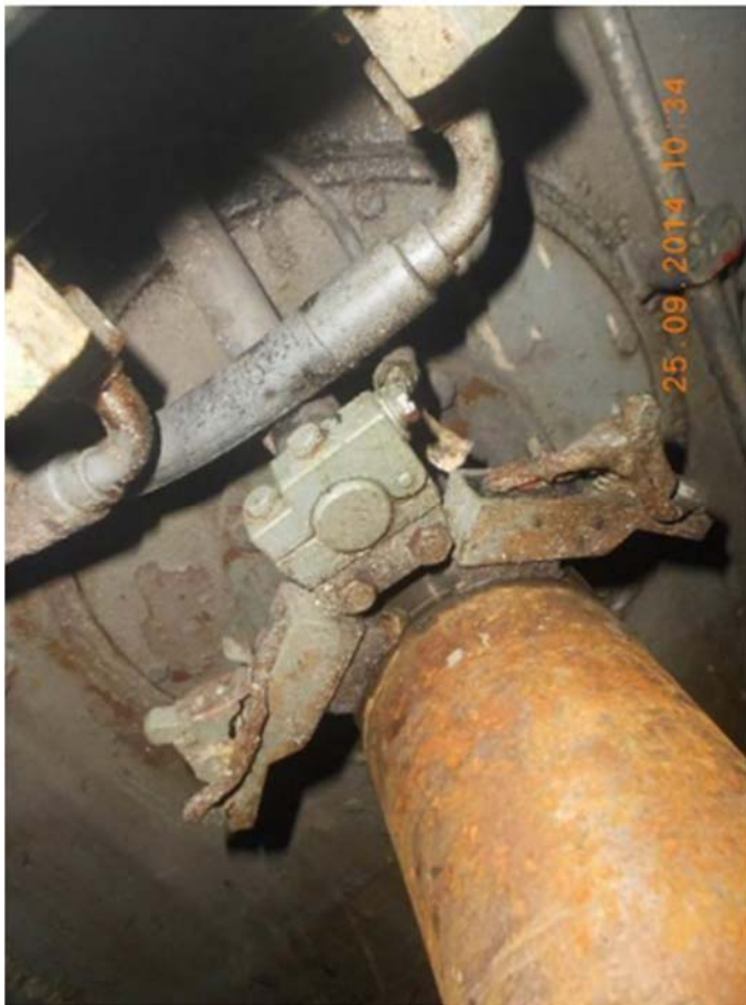
Figura 7. Eje de cola atravesando mamparo de popa de cámara de máquinas
