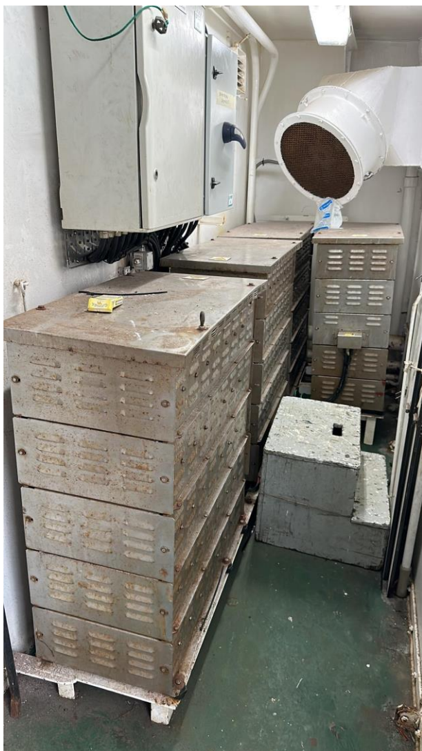
Figura 9. Resistencias de filado de un buque arrastrero (no corresponden al B/P FIGARO)
