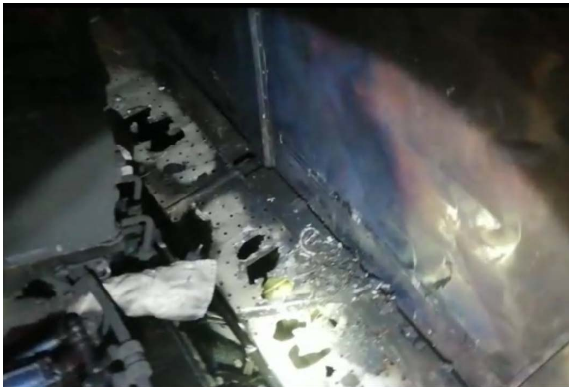
Figura 5. Patín de babor. Visión del mamparo de estribor, o interior, visto desde popa.
