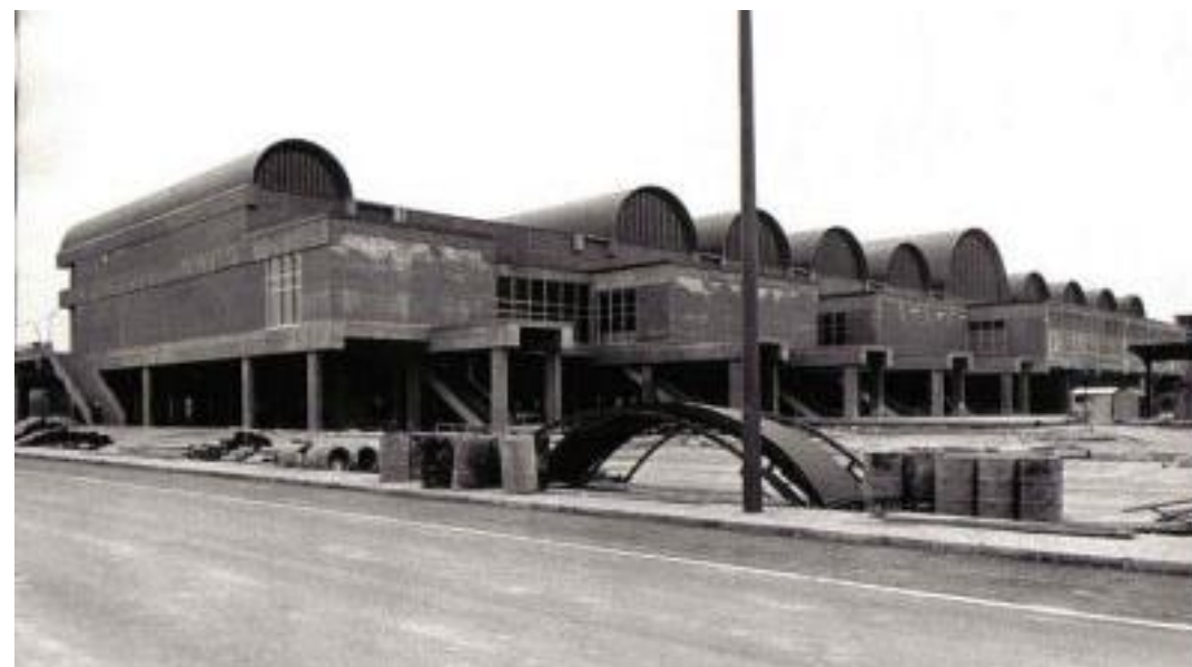
Vista del edificio de la estación definitiva en obras.
