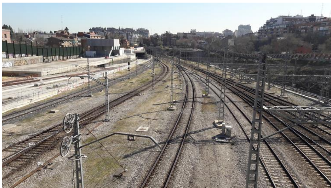
Cabecera sur. Vías de ancho ibérico hacia el túnel de Recoletos
