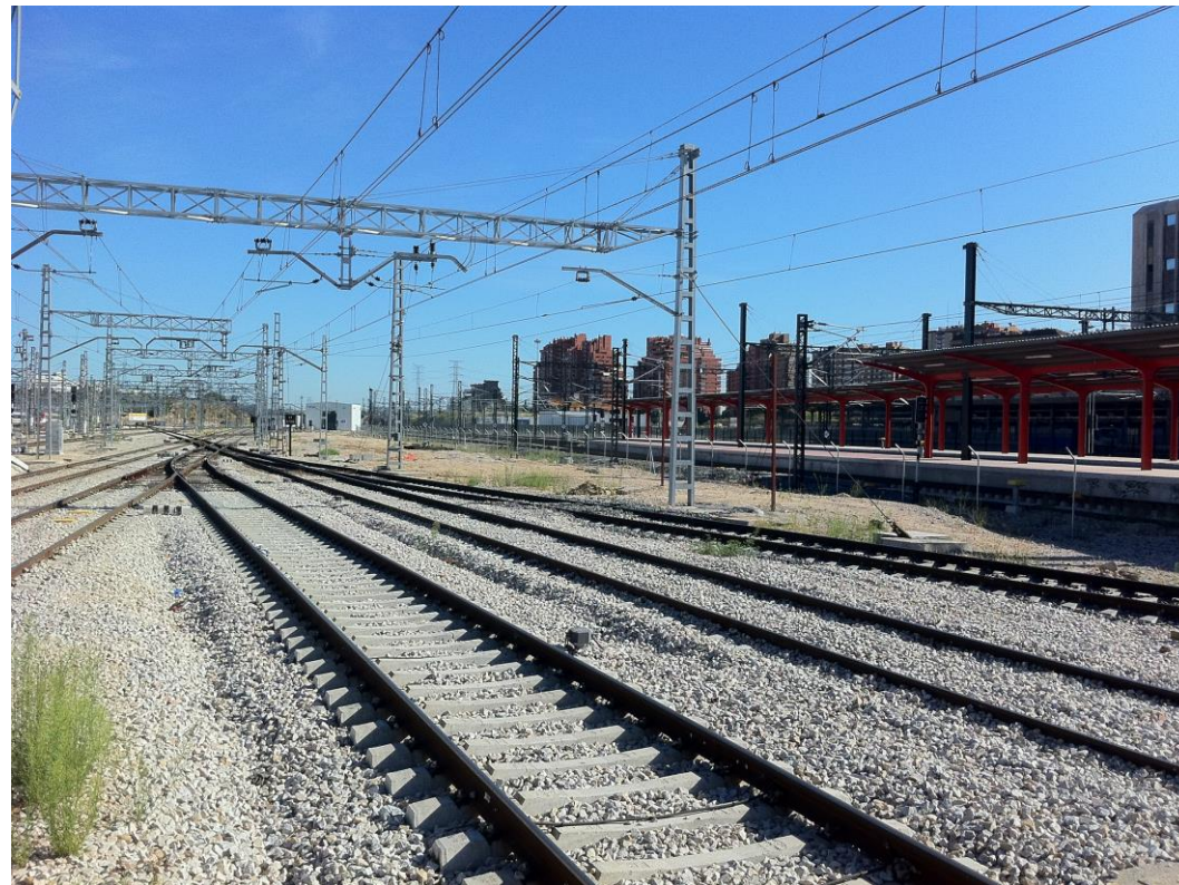
Vista hacia el Norte desde final de andenes sector Alta Velocidad
