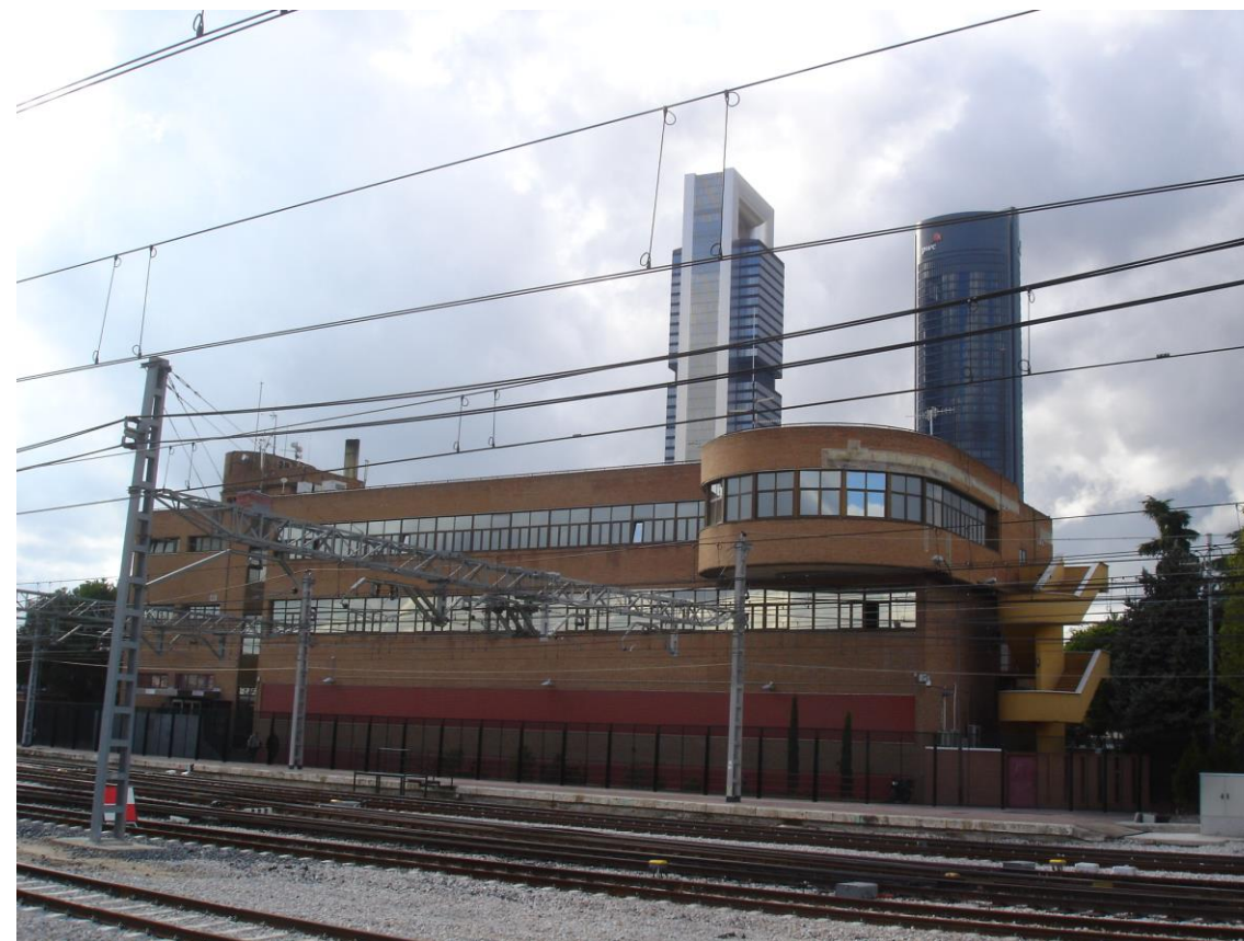
Vista del Edificio de Puesto de Mando
