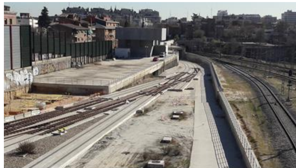
Cabecera sur. Vías de ancho UIC hacia túnel Atocha-Chamartín
