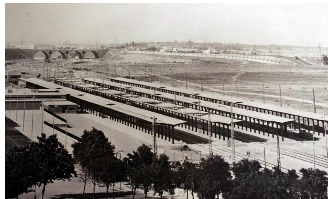
Vista de la playa de vías con andenes y marquesinas.
