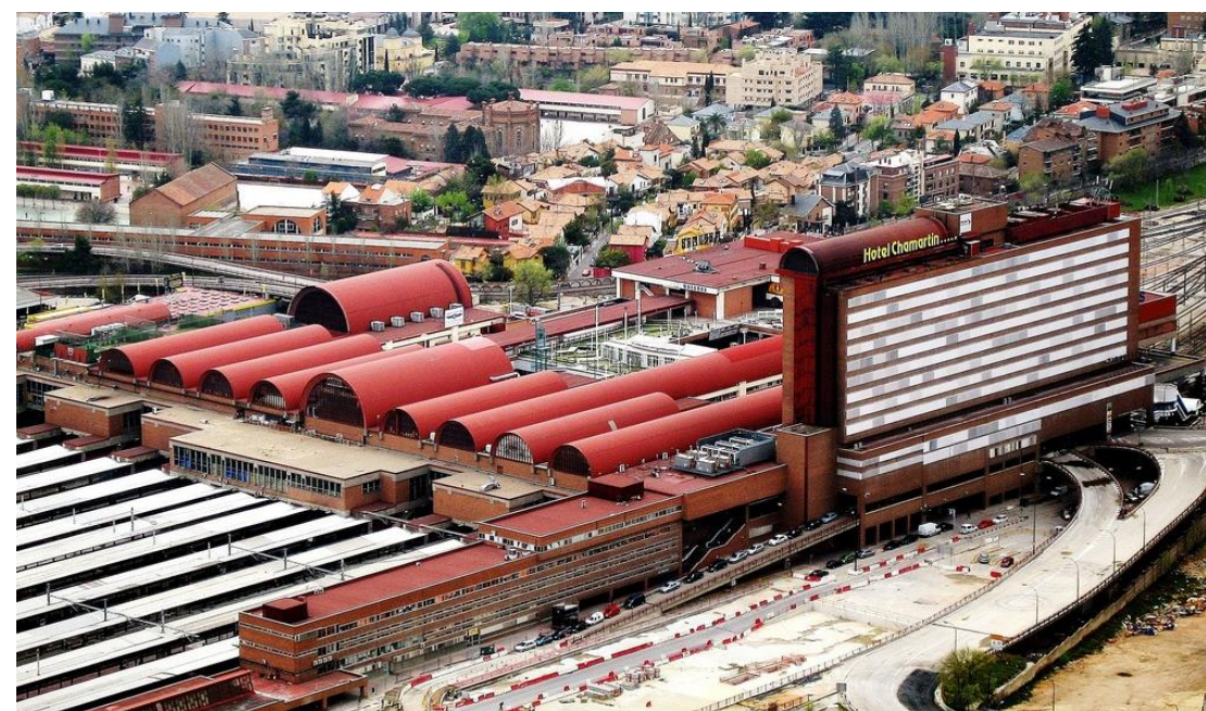
Vista del conjunto de la estación desde el oeste
